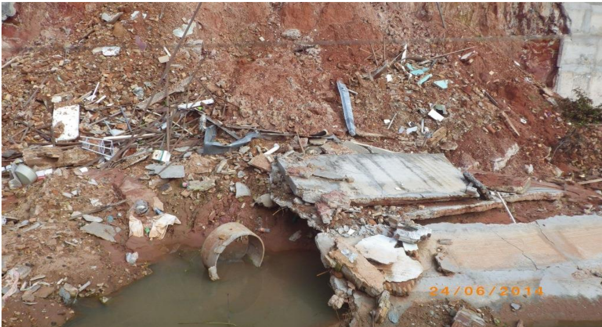
Restos da cortina atirantada
