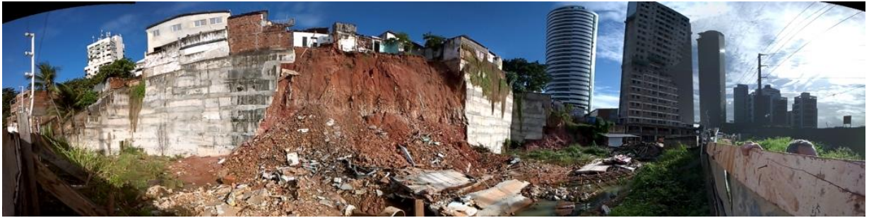
Vista panorâmica da área atingida pelo escorregamento / tombamento da cortina atirantada
