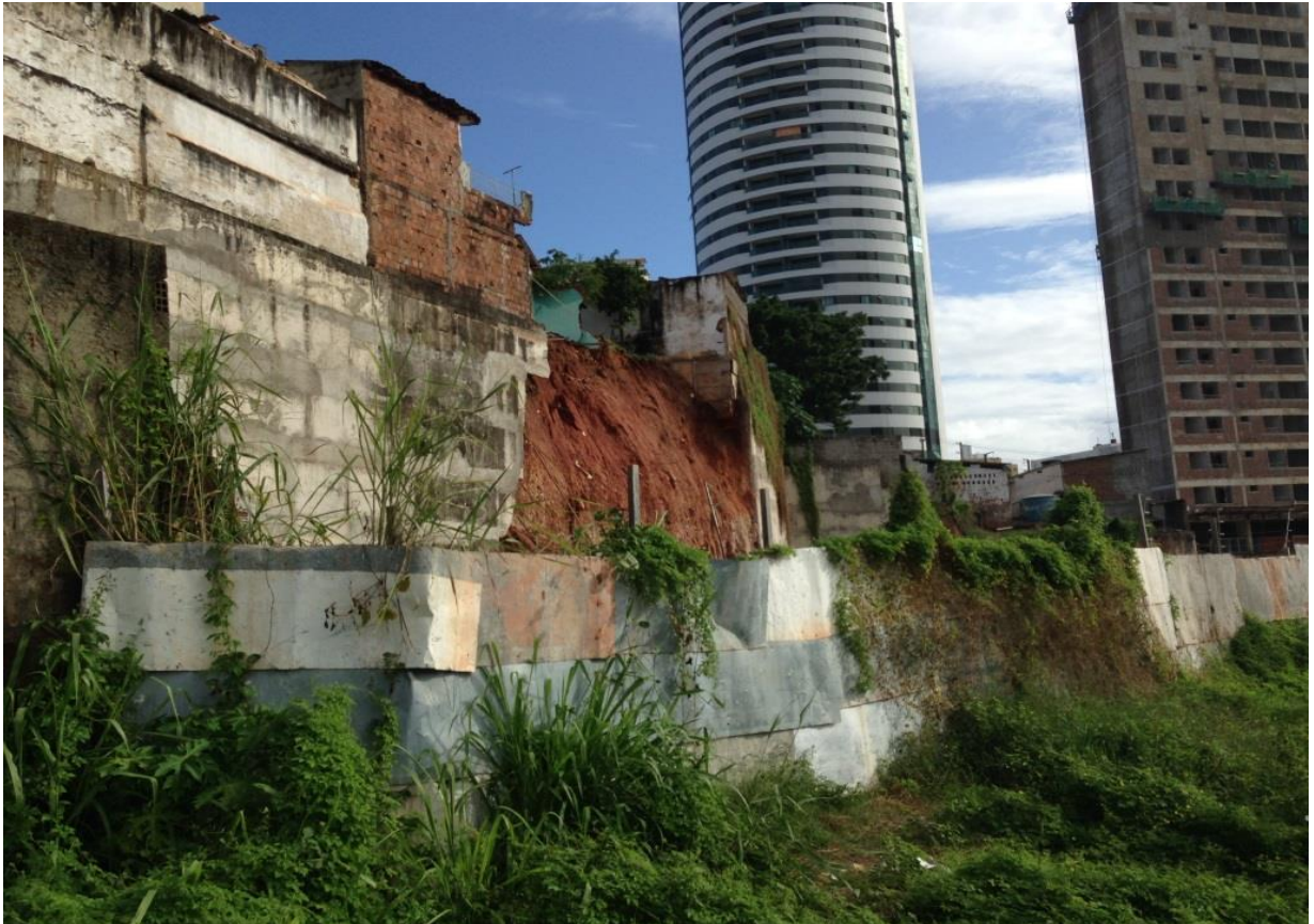
Vista panorâmica da área atingida pelo escorregamento / tombamento da cortina atirantada
