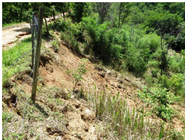
Imagem de deslizamento na encosta
