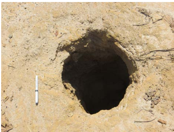
Imagem de sumidouro no topo da encosta
