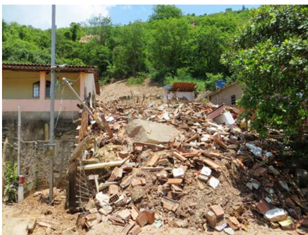
Imagem de casa destruída por corrida de detritos
