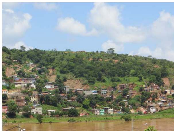
Imagem da vista da encosta
