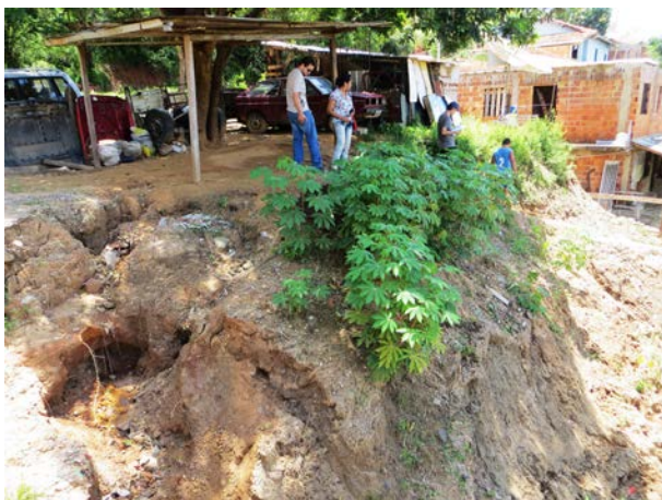
Imagem da borda do talude
