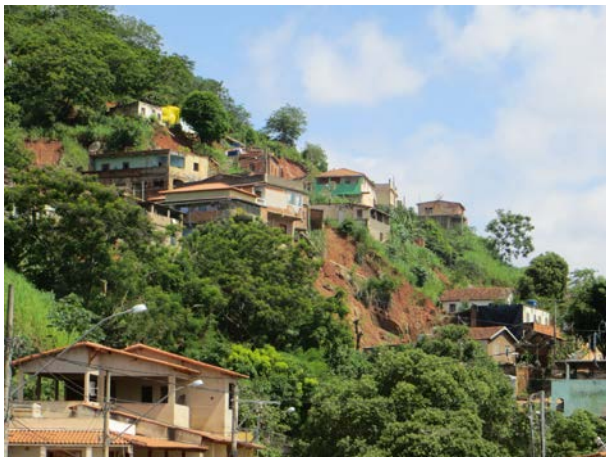
Imagem da rampa da encosta
