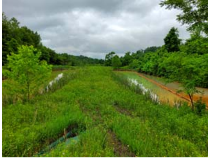
Figura 3. Estação de tratamento passivo de DAM.
