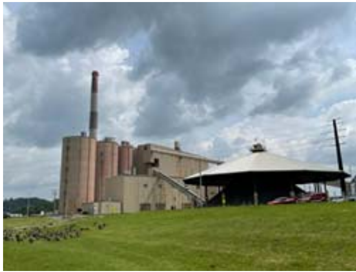
Figura 18B. Termoelétrica para queima de rejeitos de carvão e pátio de estocagem de calário.
