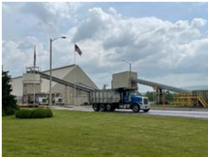
Figura 18A. Termoelétrica para queima de rejeitos de carvão.
