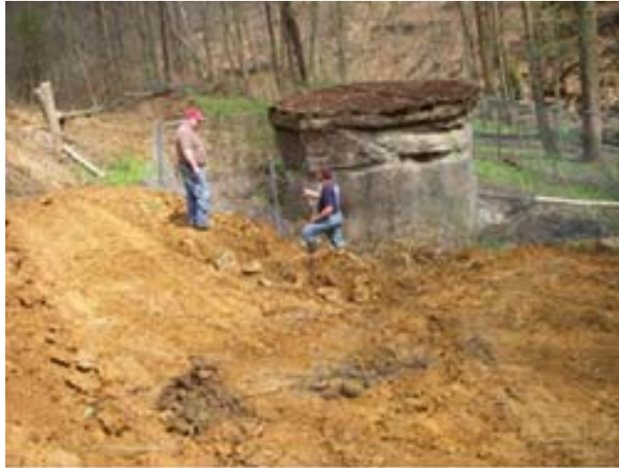
Figura 11A. Detalhe da época de construção do selo de fechamento.
