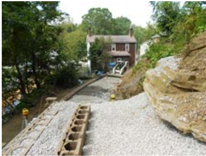
Figura 8C. Detalhe da edificação do muro de contenção.
