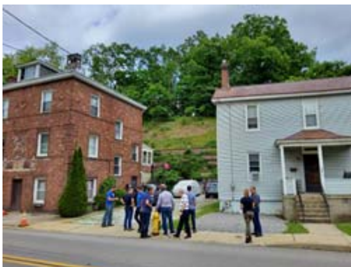
Figura 8A. Obra de contenção para conter pilhas de rejeito em área urbana.
