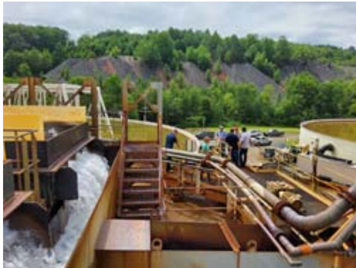
Figura 13A. Visão geral da estação de tratamento e pilhas de rejeito de carvão ao fundo.
