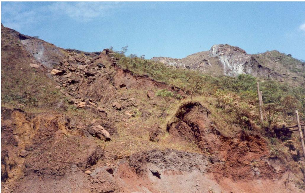
FOTO 7 – Material de bota-fora lançado sobre a vertente, com blocos e detritos em posição de instabilidade.
