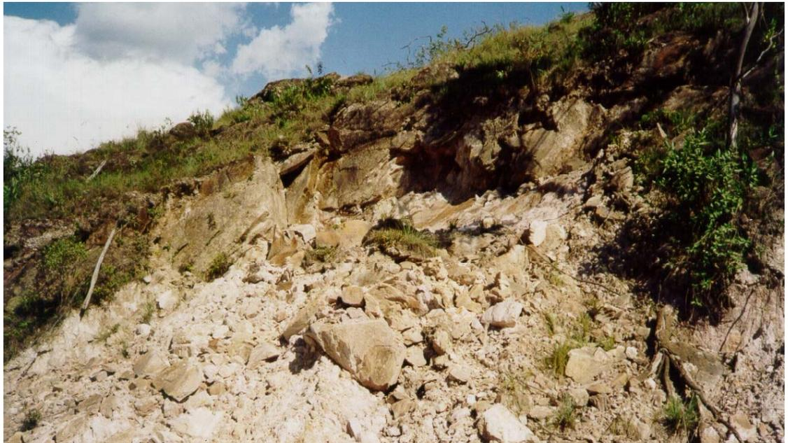
FOTO 5 – Ruptura em talude de quartzito fraturado, condicionada pelas discontinuidades.
