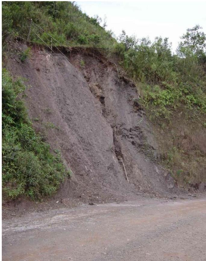
FOTO 13 – Ruptura em talude verticalizado em xisto alterado e solo saprolítico.
