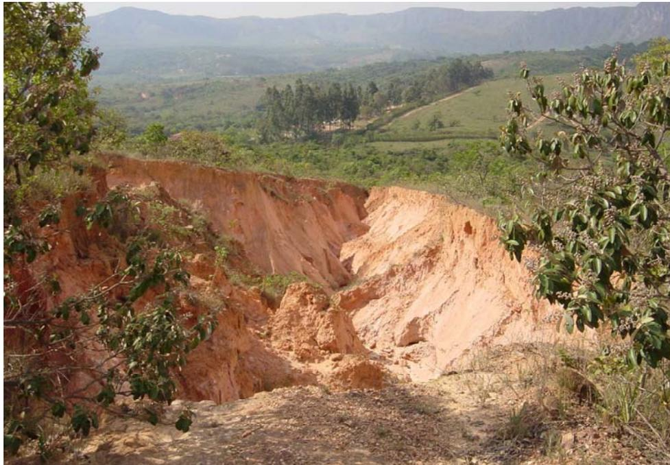
FOTO 4 – Ravina controlada por plano de falha aflorando no leito de arruamento sem revestimento.
