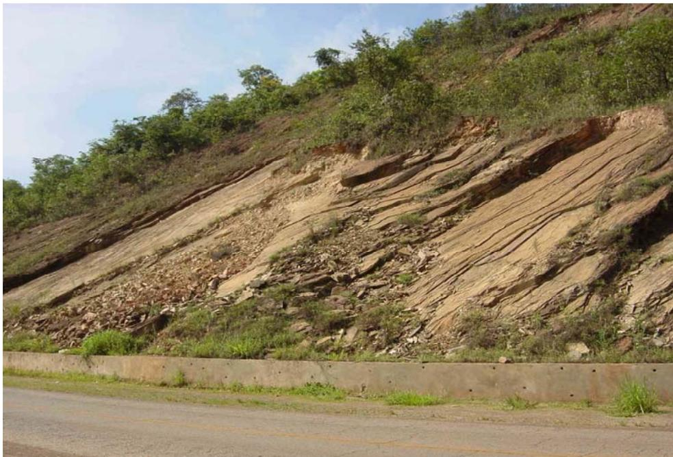
FOTO 10 – Ruptura planar em talude de xisto pouco alterado, com capa de colúvio de pequena espessura.
