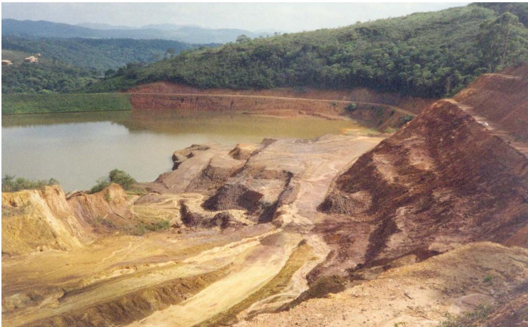
FOTO 9 – Ombreira de barragem de rejeitos com sulcos e trincas nas bermas.
