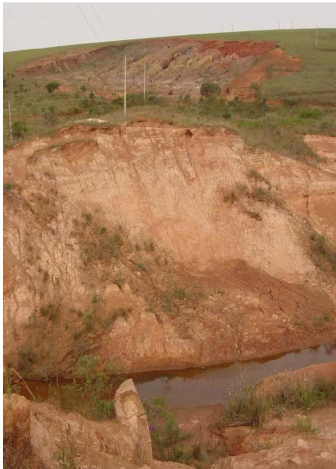
FOTO 15 – Antigo eixo de barramento, com área de empréstimo com sulcos.
