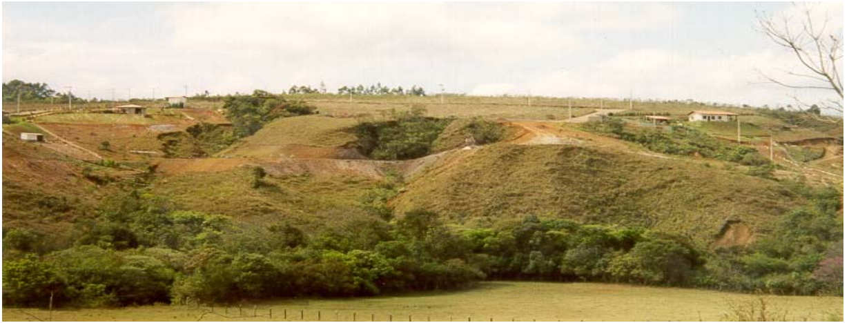
FOTO 14 - Voçorocas em área de expansão de condomínios de alto padrão construtivo. O eixo de drenagem de uma das voçorocas está barrado por aterro para implantação de uma estrada vicinal.
