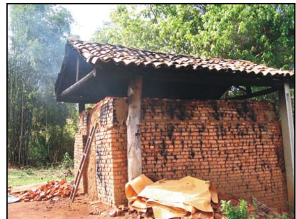
Figura 45: Forno para queima de tijolos, com capacidade para cerca de 12.000 unidades em cada queima. Região de Barro Preto – Piumhi.
