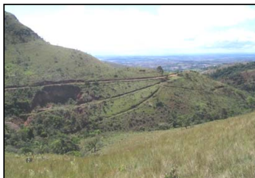
Figura 48: Frente de lavra desativada de cromita na Serra Lava-Pés, próximo a Piumhi.
