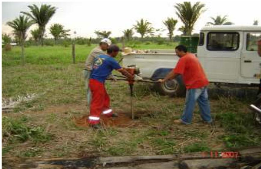
Figura 32. Perfuração a trado motorizado na Área 6.
