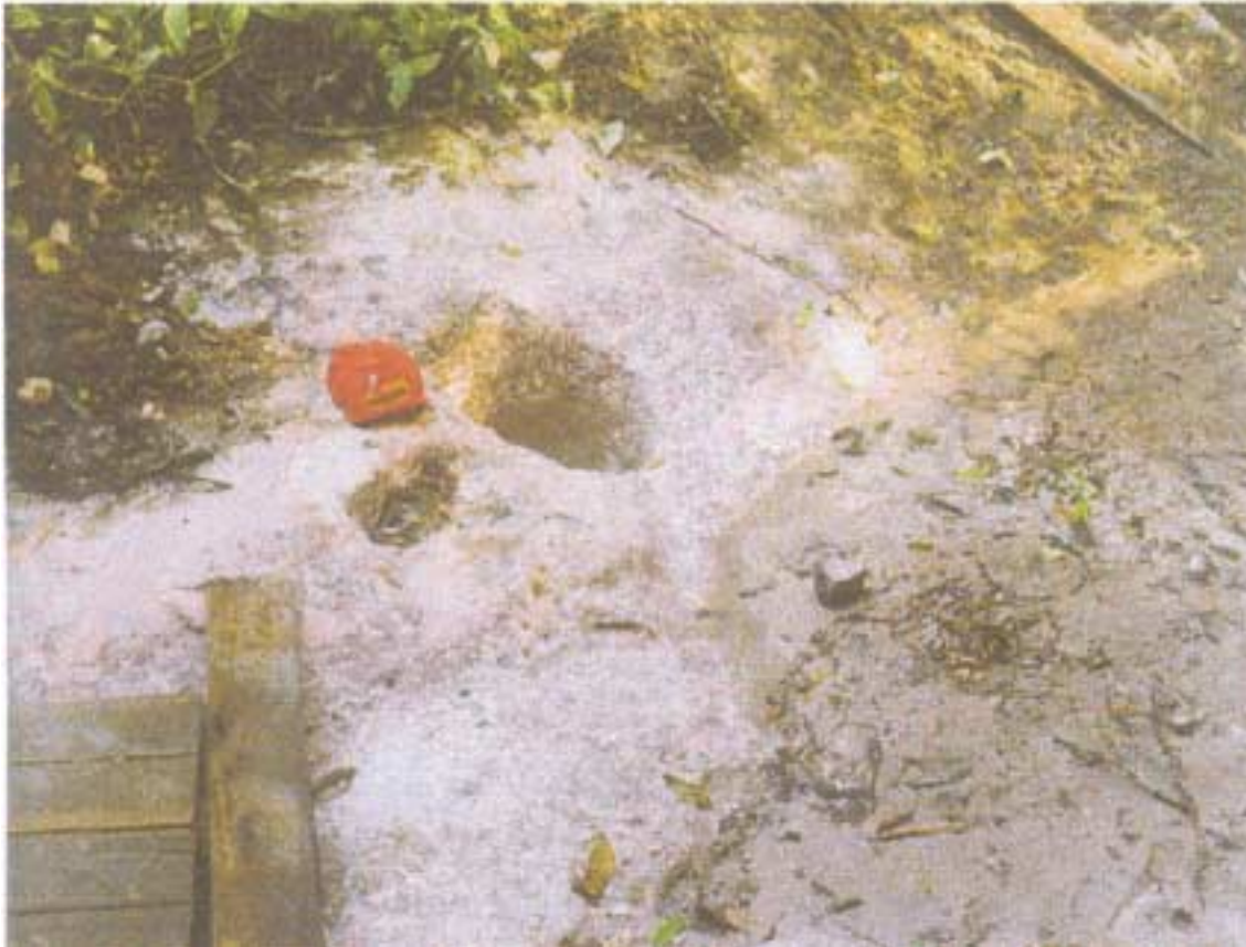
Foto 18 – Surgência d'água no trecho superior da voçoroca de Camarazinho.
