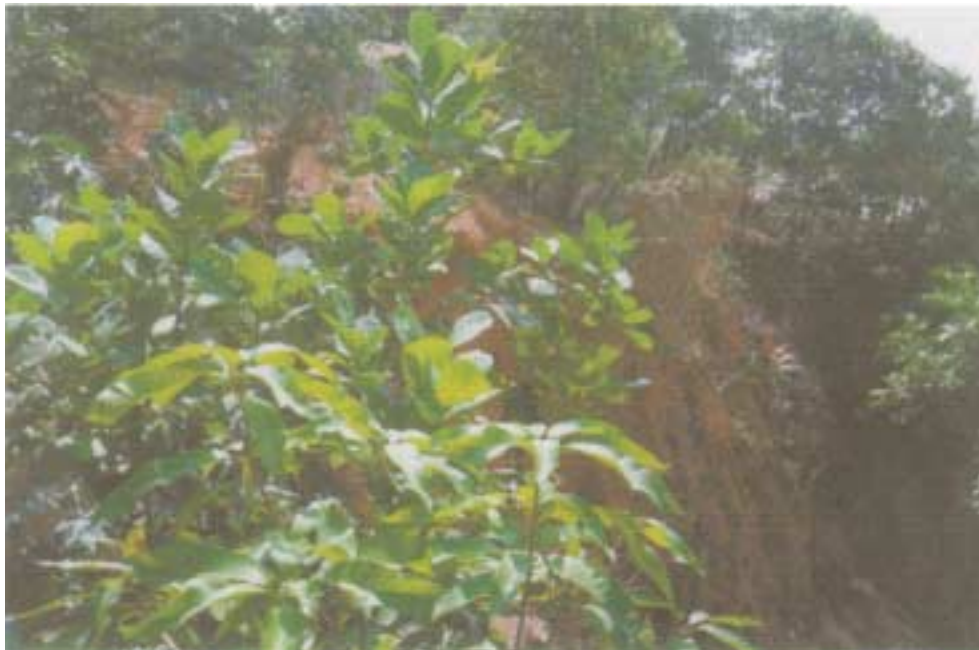
Foto 02 - Observa-se a movimentação do terreno próximo ao talude em função da inclinação das árvores e da cerca. Essa foto é uma visão localizada do 4º braço esquerdo da voçoroca do Curaxi.
