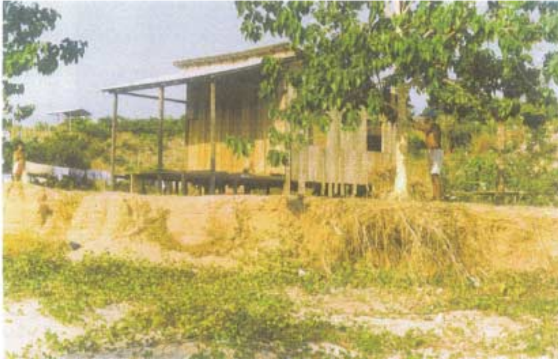
Foto 12 – Ocupação próxima à margem erodida do canal do Curaxi.
