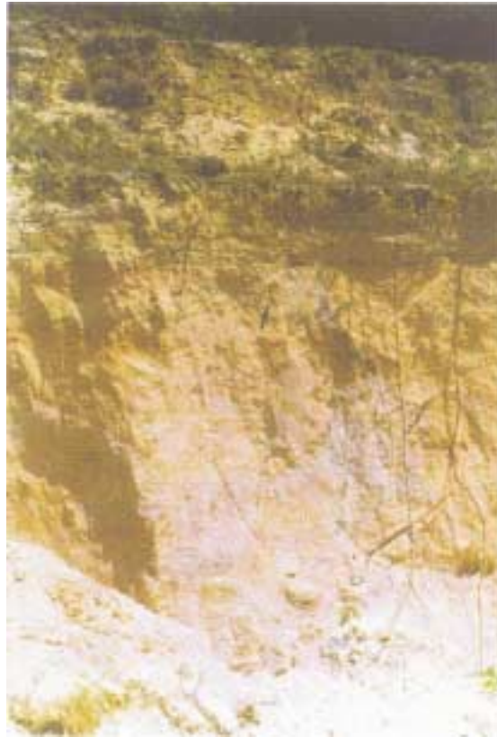
Foto 06 – Arenito muito friável da Formação Alter do Chão subjacente a depósitos arenosos recentes (solo aluvial) com estratificação horizontal (baranco da voçoroca do Curaxi).
