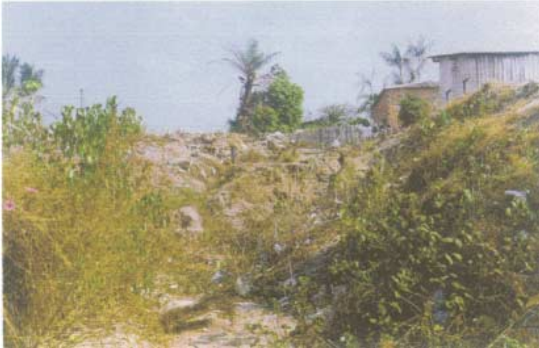
Foto 14 – Aspecto das cabeceiras da voçoroca de Camarazinho.
