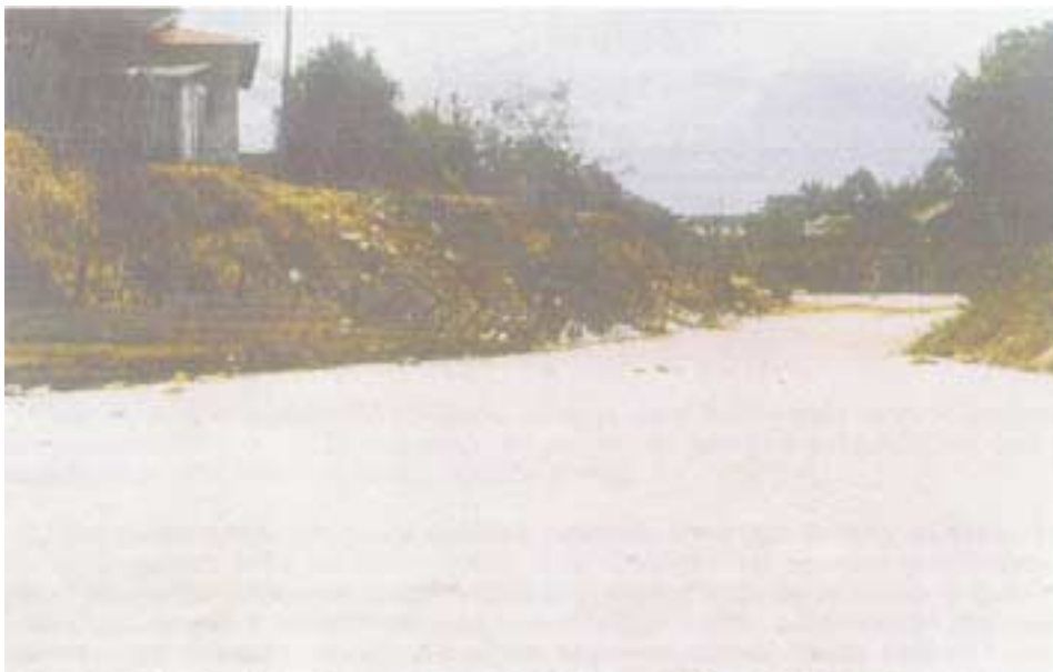
Foto 07 - Leito do canal do "Covão do Curaxi" constituído de areias aluviais, com projeções precárias das margens.
