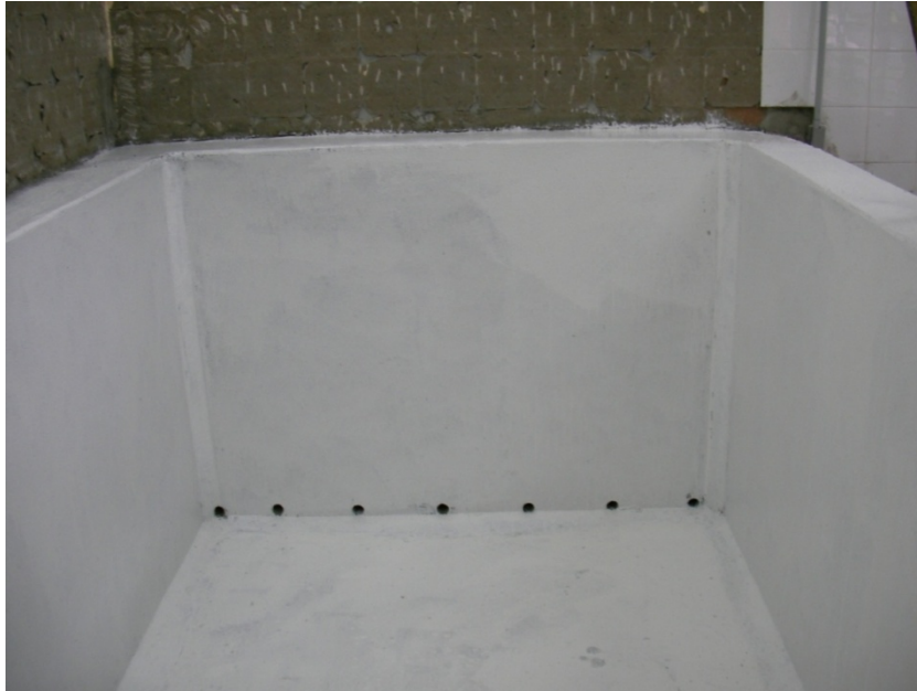
Figura I.4 - Revestimento da parte interna do tanque com material impermeabilizante.
