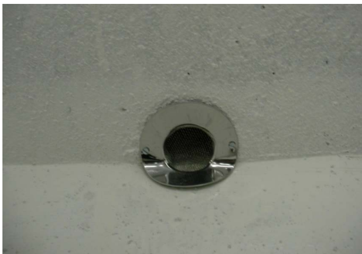
Figura I.5 - Detalhe da saída de água.
