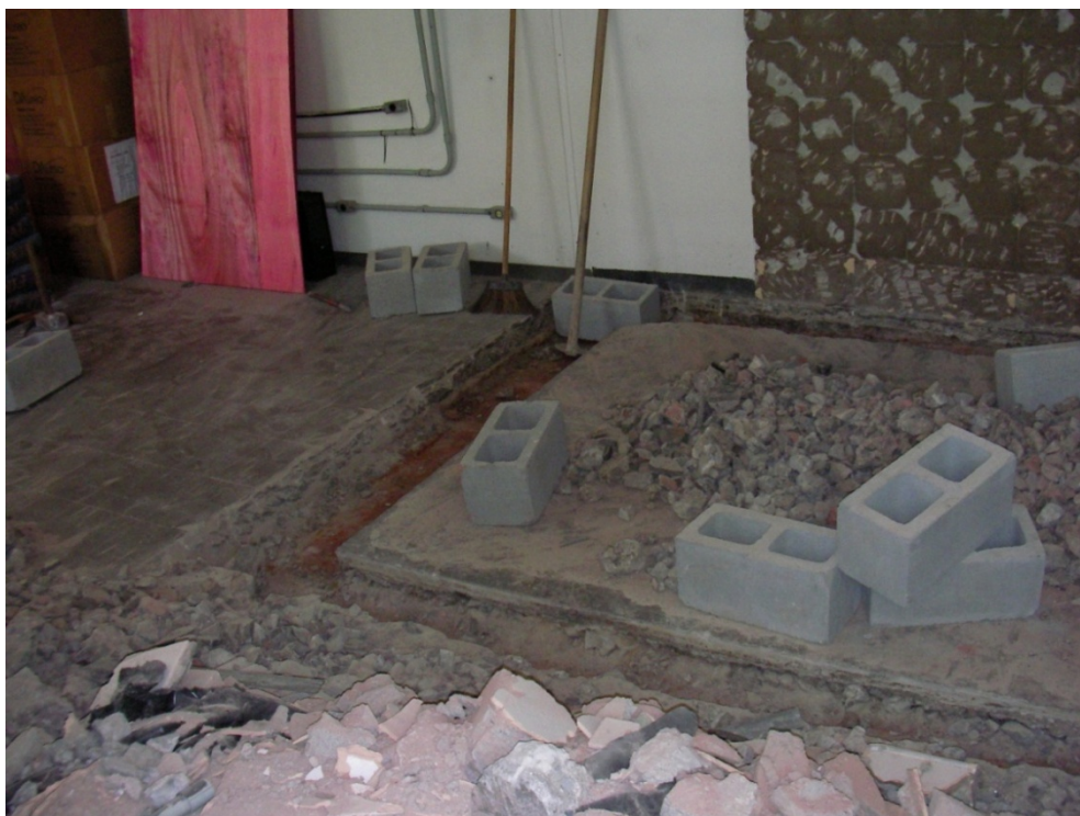
Figura I.2 - Início das obras – escavação da fundação.
