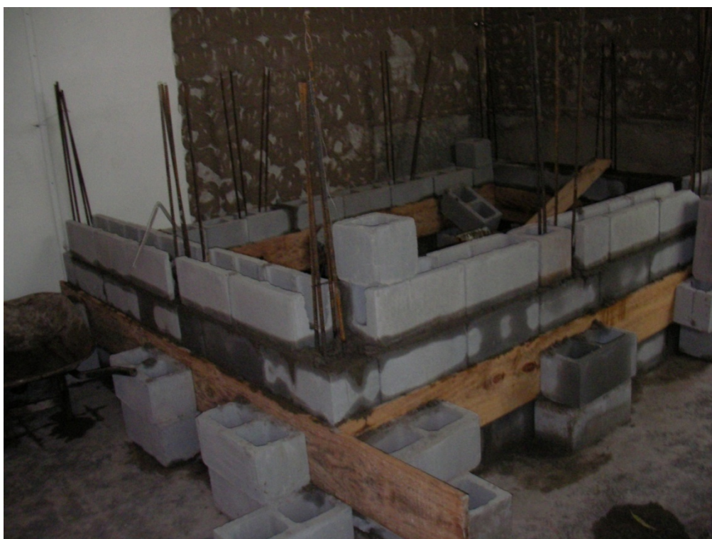
Figura I.3 - Levantamento das fiadas de bloco de concreto.
