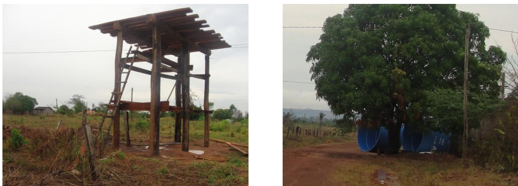
Figura 9 - Suporte para as duas caixas d'água de 10 mil litros cada (553581E, 8765397N).
