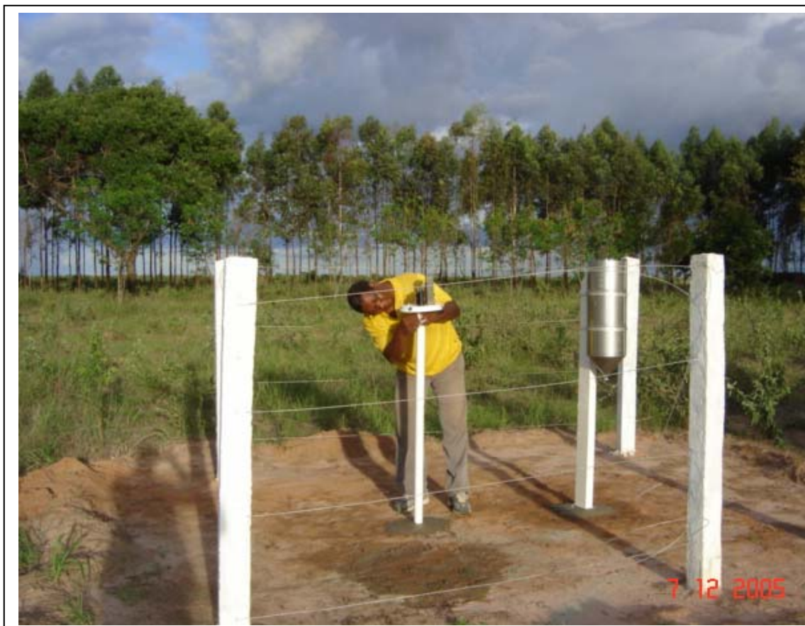
Instalação de pluviógrafo e pluviômetro para monitoramento da chuva
