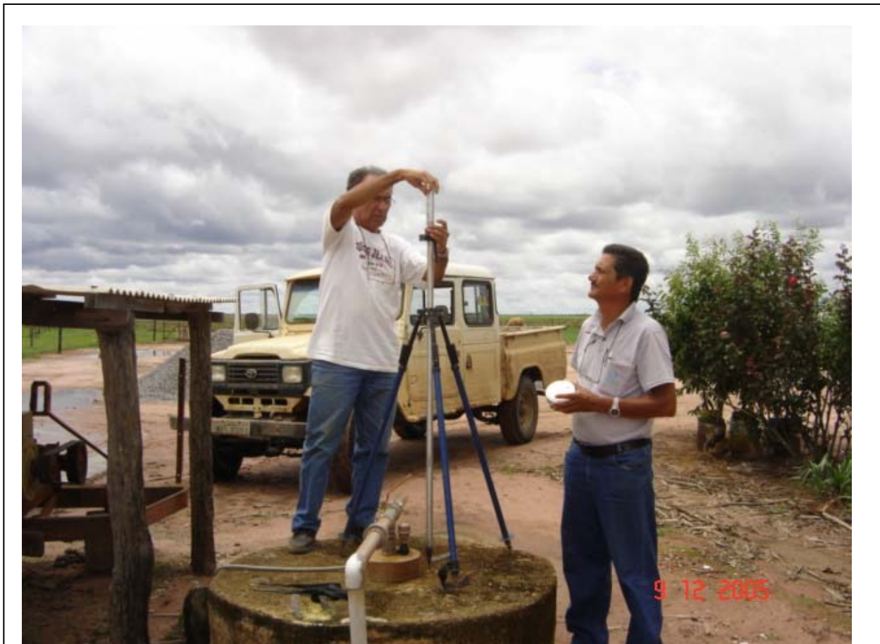
Nivelamento de pontos d'água
