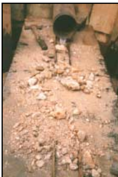
Foto 16 - Seixos extraídos por ocasião do desmonte para instalação dos drenos
