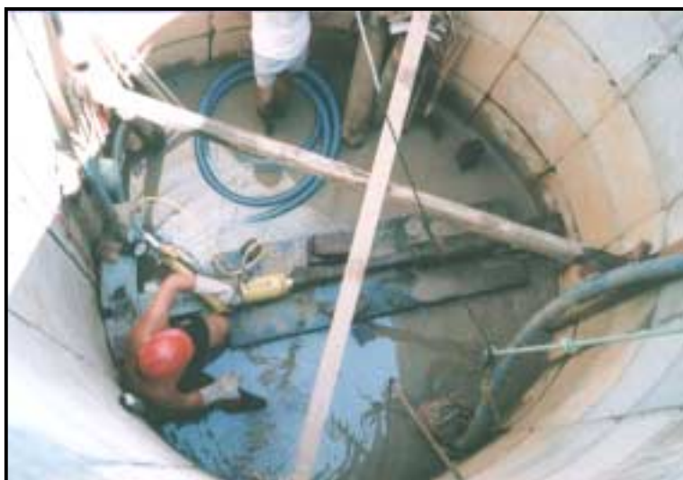
Foto 7 - Prensamento com cilindro hidráulico dos tubos de 6 5/8"
