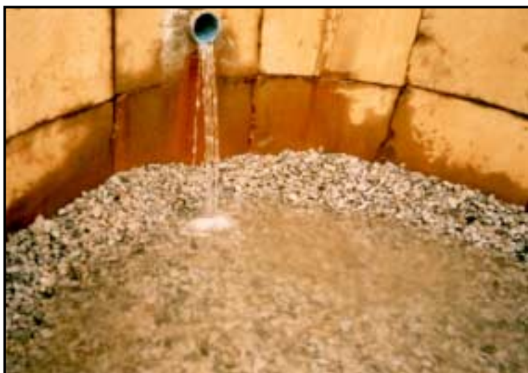
Foto 20 - Instalação de fundo com brita nº 19
