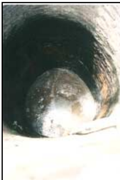
Foto 15 - Fonte de abastecimento d'água da Vila de Mandaçaia
