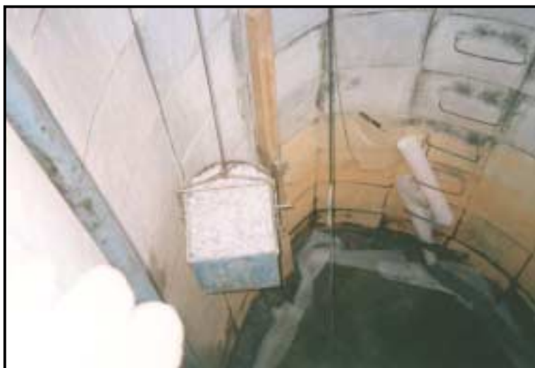
Foto 22 - Caçamba com capacidade de 90 litros para extração de material de desmonte
