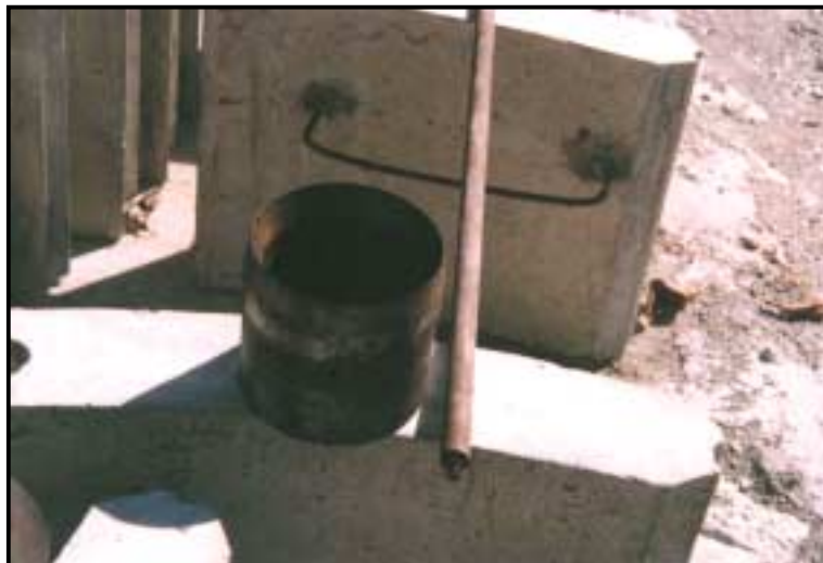
Foto 6 - Sapata cortante utilizada na perfuração dos drenos e um tubo centralizador de 1"
