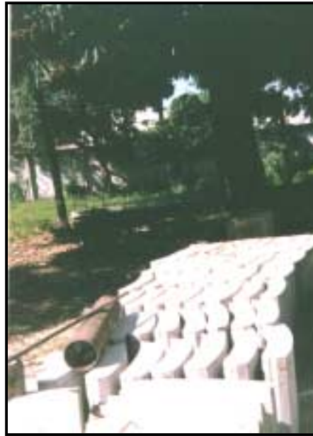
Foto 5 - Tubo de 6 5/8" com rosca tipo caixa para perfuração dos drenos
