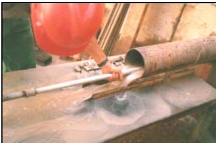
Foto 9 - Sistema de desmonte hidráulico com jato de 5/16"
