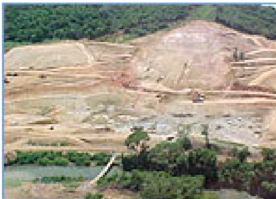
Figura 1C - Escavação (novembro/2002). Fonte: SANEAGO (2005).
