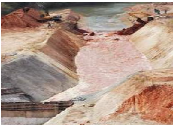
Figura 5C - Liberação da passagem das águas do ribeirão João Leite pelo desvio. Fonte: SANEAGO (2005).
