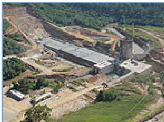
Figura 8C - Vista geral de jusante (maio/2004). Fonte: SANEAGO (2005).
