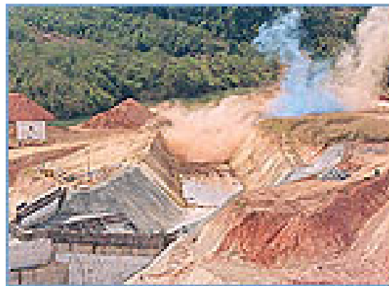
Figura 2C - Desvio do leito do rio (agosto/2003). Fonte: SANEAGO (2005).
