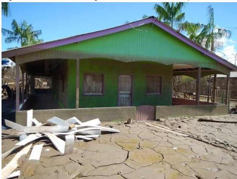
Figura 22: Imóvel residencial em São Carlos. Observar nível da água indicado na casa e depósitos de sedimentos depositados durante a inundação
