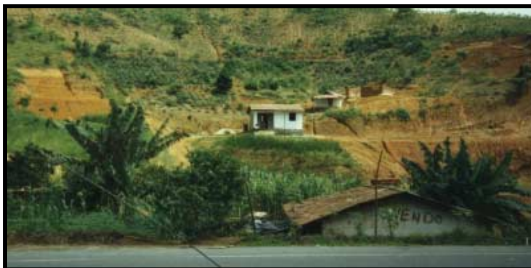
Foto 6 - Ocupação de Encostas com Cortes de Taludes Verticais. Rodovia PE - 60.
