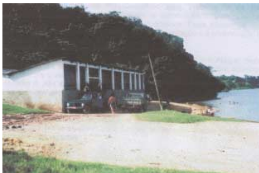
Foto 23 – Matadouro municipal, localizado na margem esquerda do rio Gurupatuba, lançando os rejeitos do abate de animais no referido rio.
