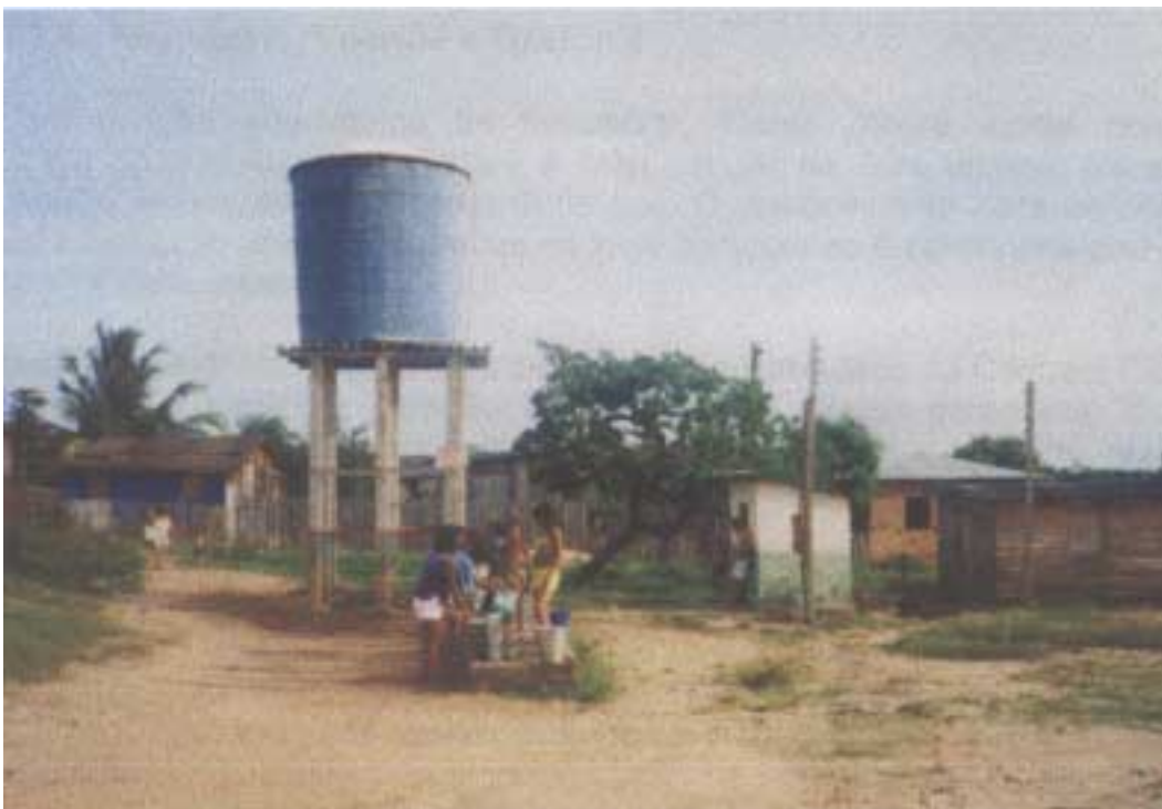
Foto 10 - Poço e elevatório de 20m 3 da Prefeitura na Av. Nilo Peçanha, atendendo o público com 8 torneiras comunitárias.
