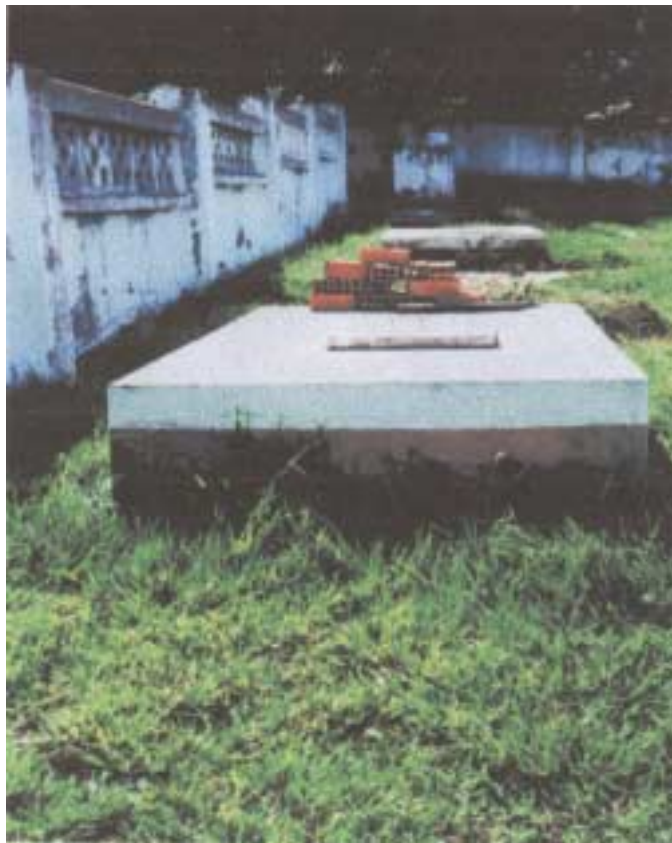
Foto 22 – Incinerador ao fundo e poços impermeáveis, usados respectivamente para queima ou armazenamento dos rejeitos das salas de cirurgias e laboratório.
