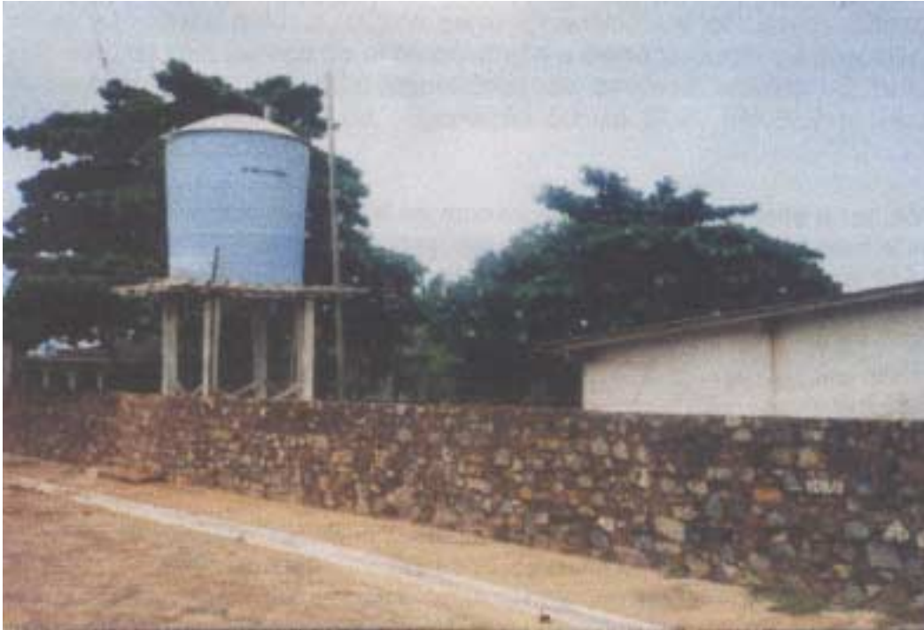
Foto 9 – Elevatório de 30 m 3 localizado na residência Oficial do Prefeito.
