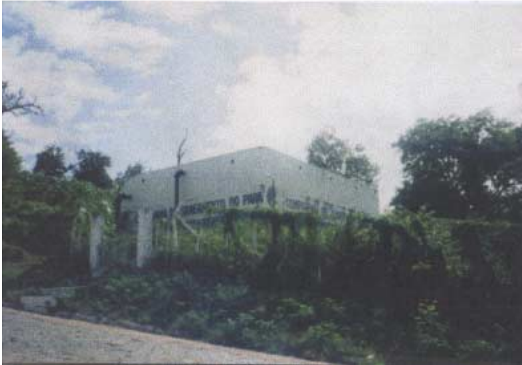
Foto 7 – Reservatório semi enterrado de 400 m3 da Lauro Sodré.
