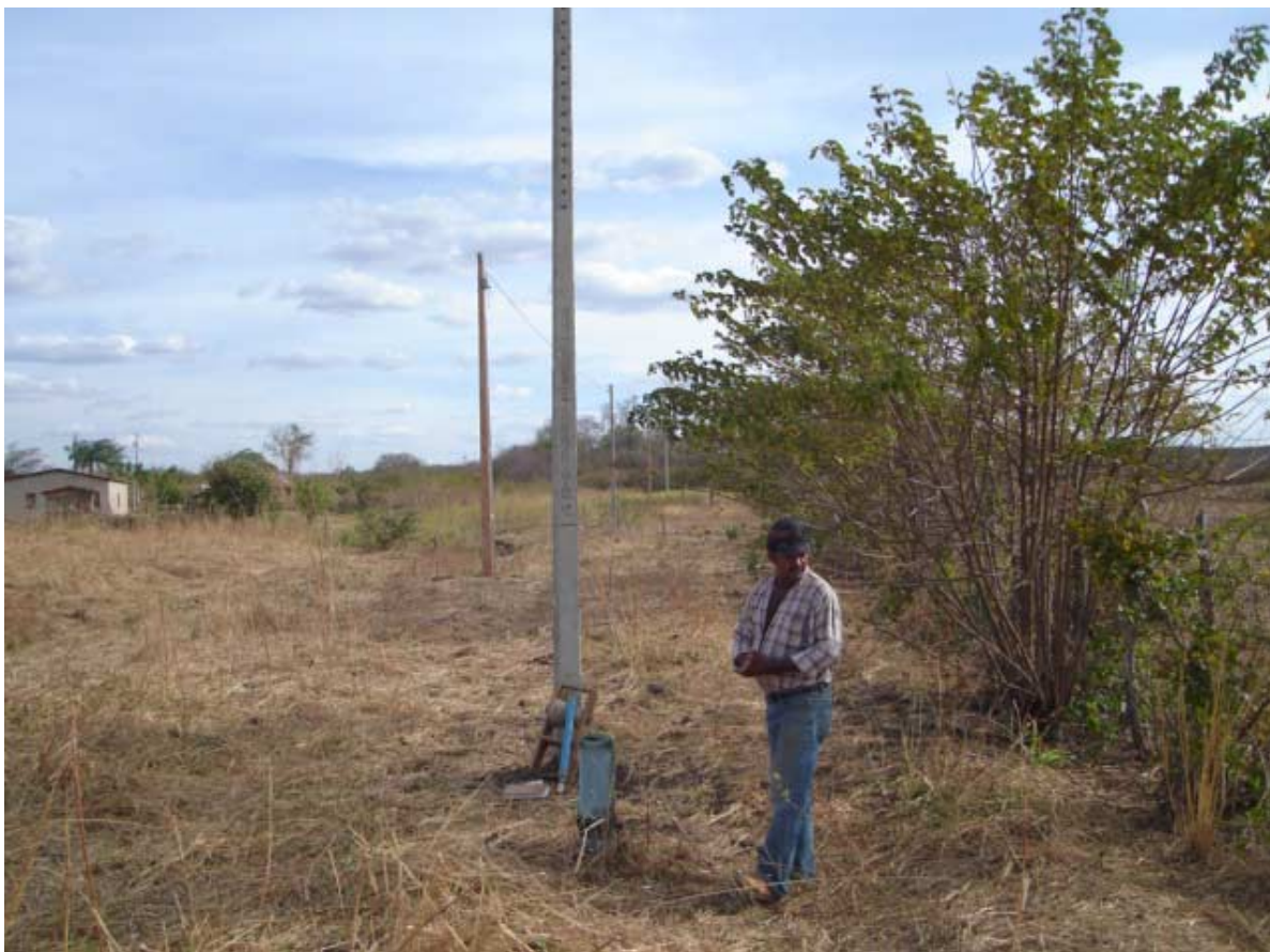
Foto 2.1 - Situação pretérita do poço Sítio Baixio dos Costas
