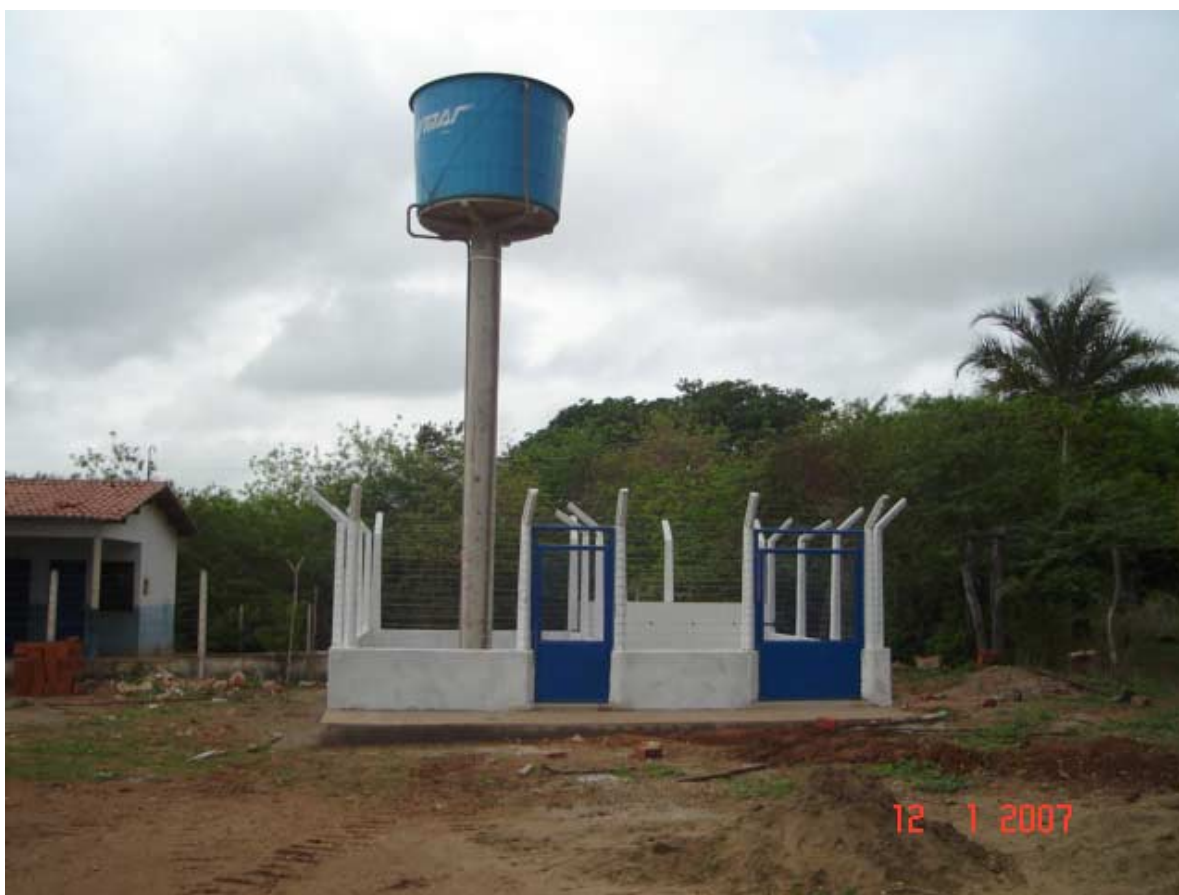
Foto 6.1 - Caixa d'água elevada com capacidade para 5.000 litros
