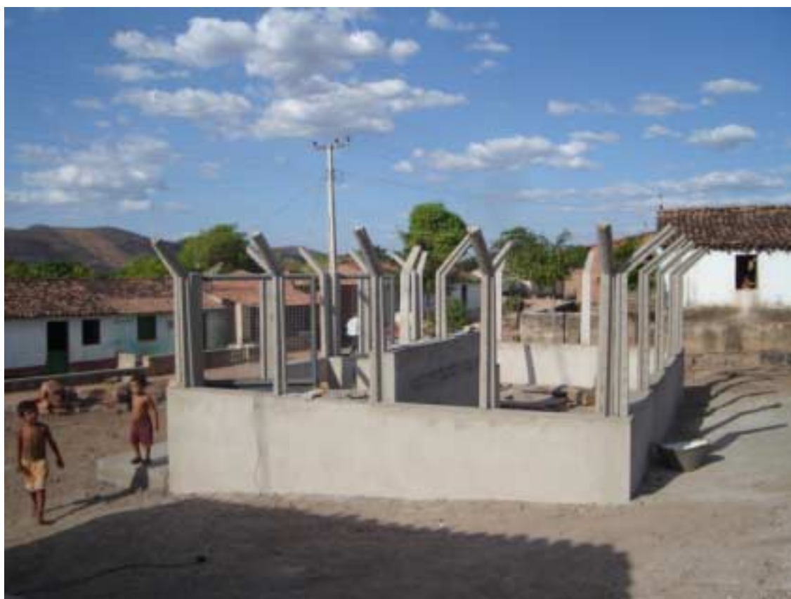
Foto 7.1 - Arranjo físico das estacas pré-moldadas
