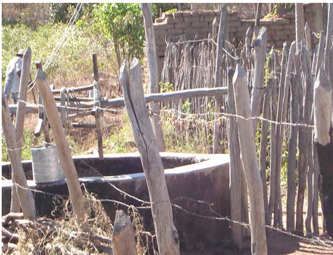
Foto 2.1 - Situação pretérita do poço
