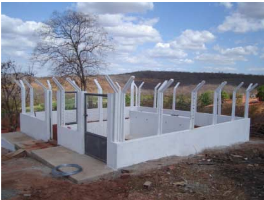
Foto 7.2.1 - Estacas de concreto armado, com inclinação de 45°
