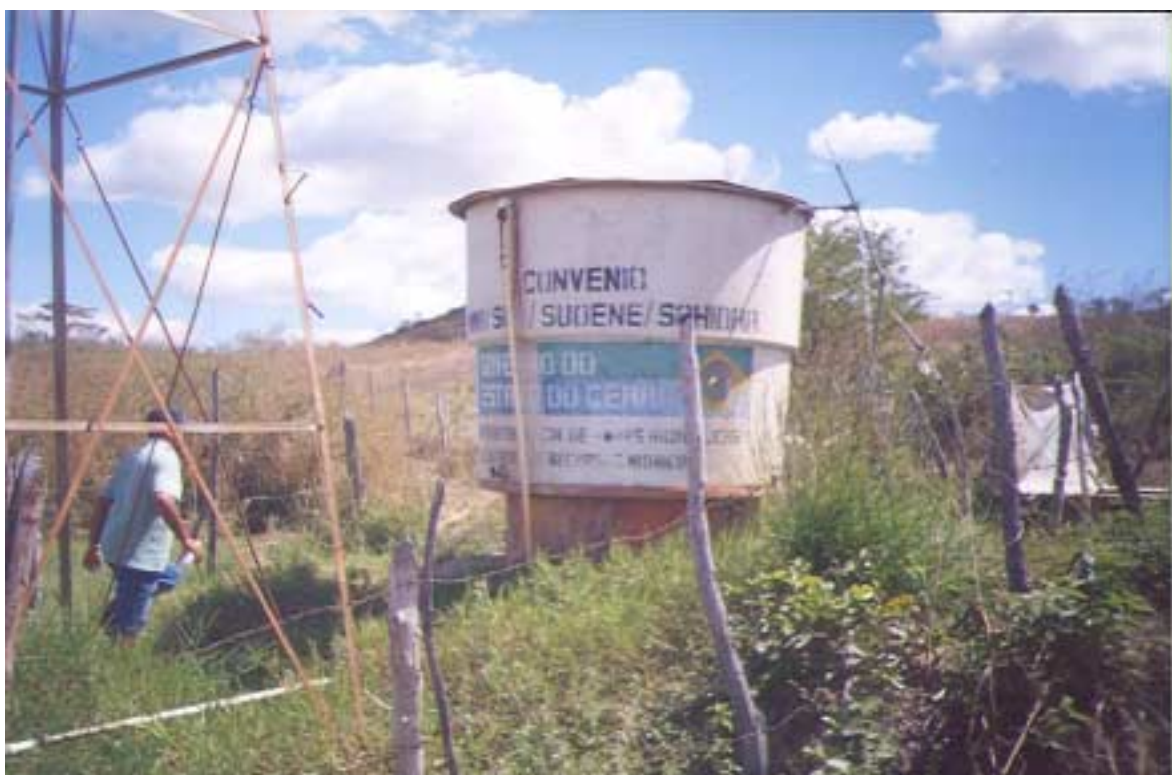
Foto 2.1 - Situação pretérita do poço
