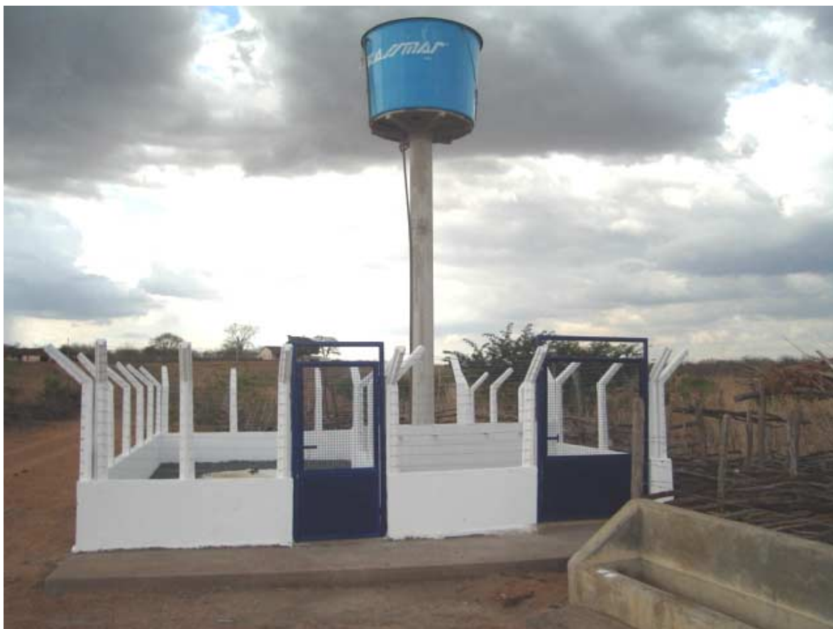
Foto 7.1 - Aspecto do SSA Sítio Gangorra concluído
