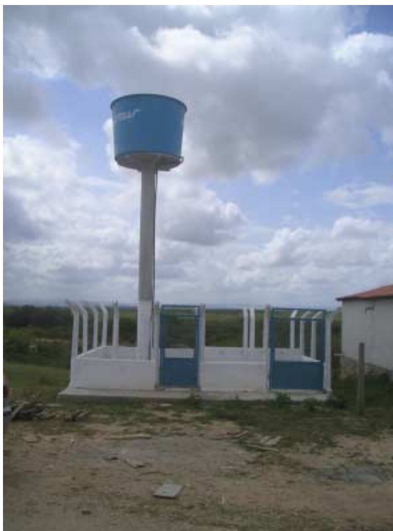
Foto 7.2 – Instalações do SSA Torrões concluído
