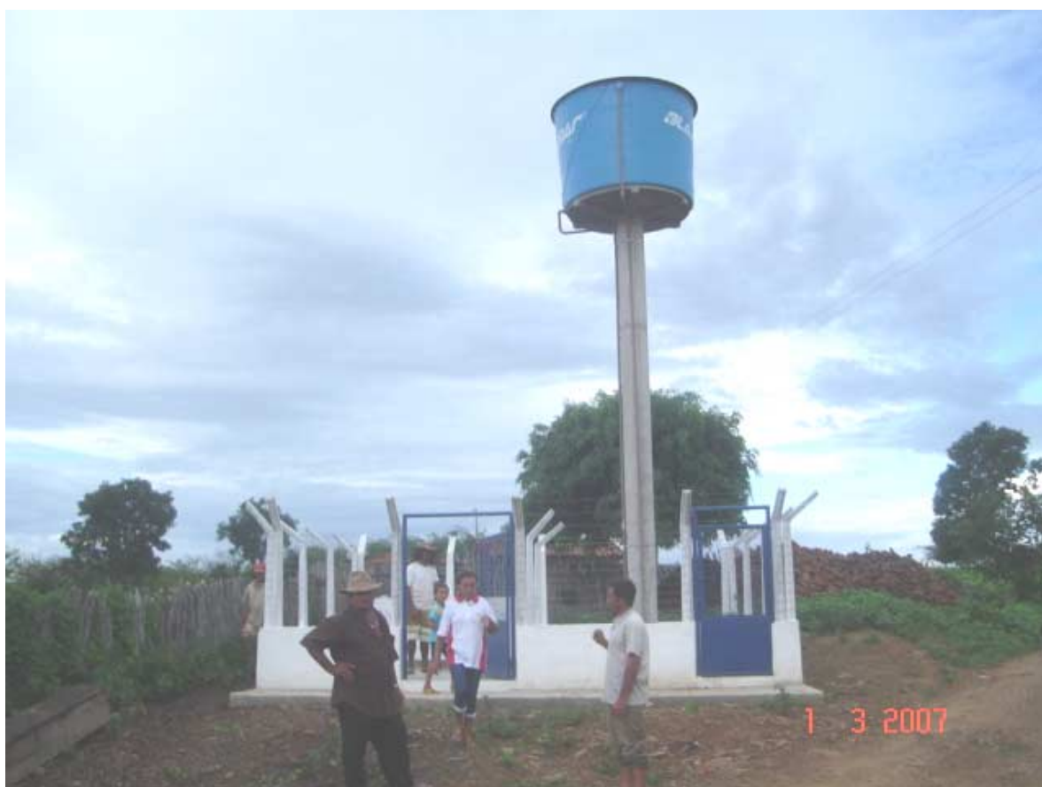
Foto 8.1 - Aspecto do SSA do Sítio Várzea Comprida concluído
