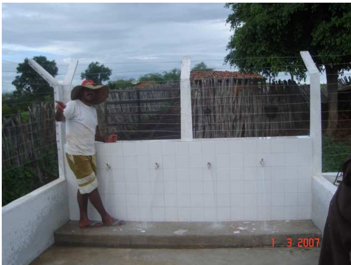
Foto 7.1 - Fase construtiva do SSA Sítio Várzea Comprida
