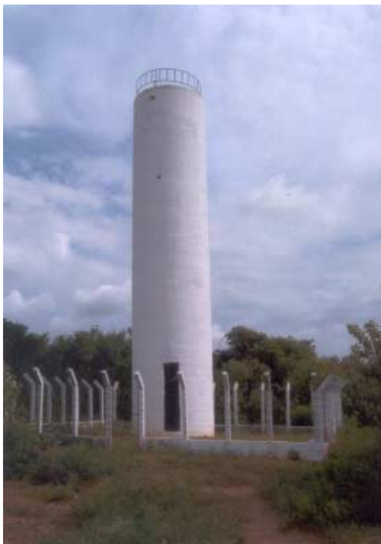
Foto 7.1 - Aspecto da caixa d'água já existente no Sítio Ipueiras
