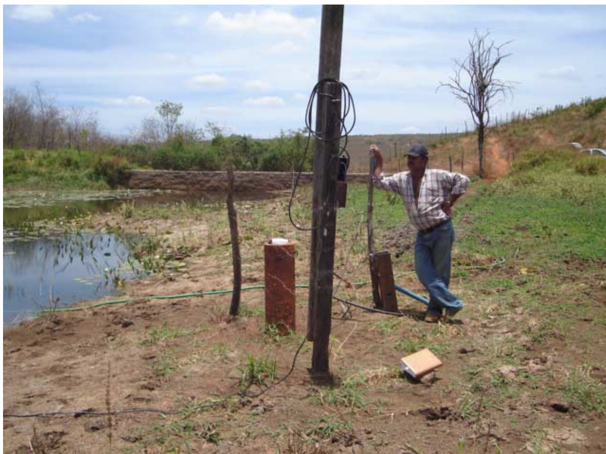
Foto 2.1 - Situação pretérita do poço do Sítio Taboquinha
