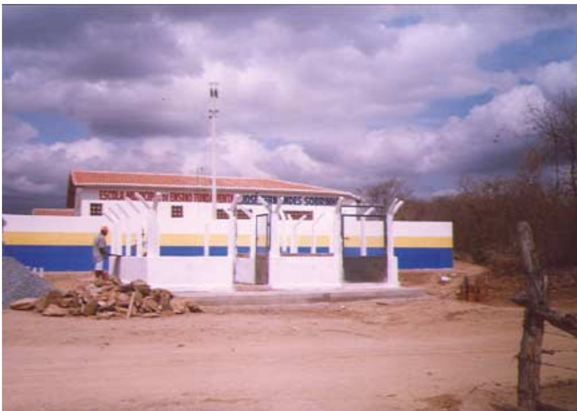
Foto 7.1 - Fase construtiva do SSA Sítio Bom Sucesso
