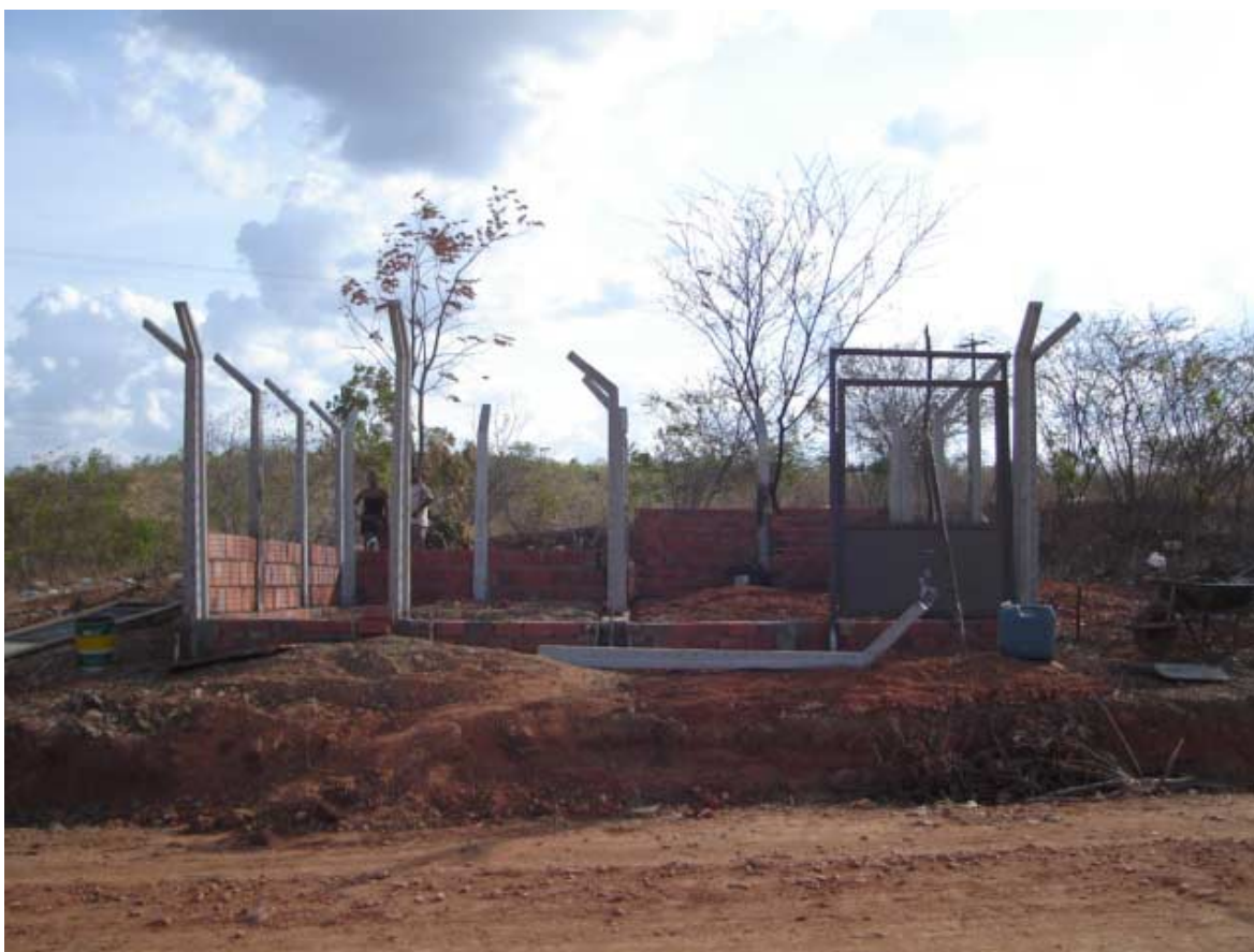
Foto 7.1 - Início da fase construtiva do SSA Sítio Boa Vista
