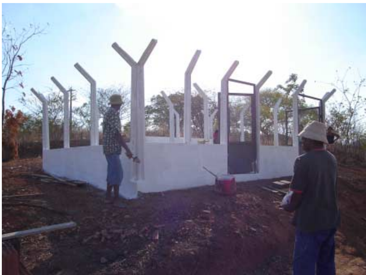
Foto 7.2 - Cercado de proteção do poço
