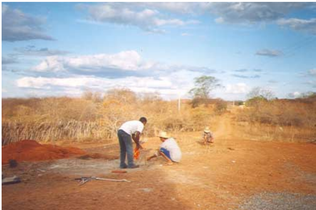
Foto 7.1 - Início da fase construtiva do SSA Povoado Boa Hora
