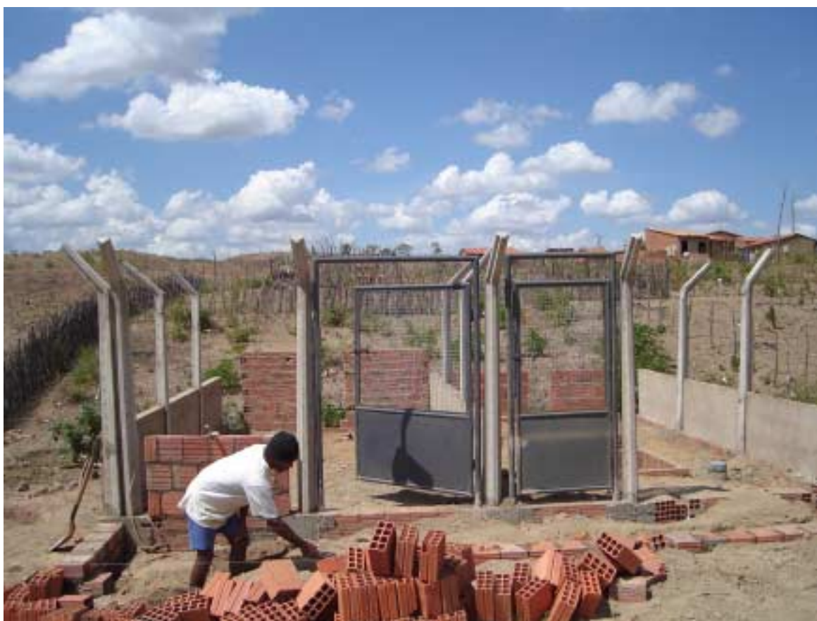
Foto 7.2 - Cercado de proteção do SSA Sítio Cidade II
