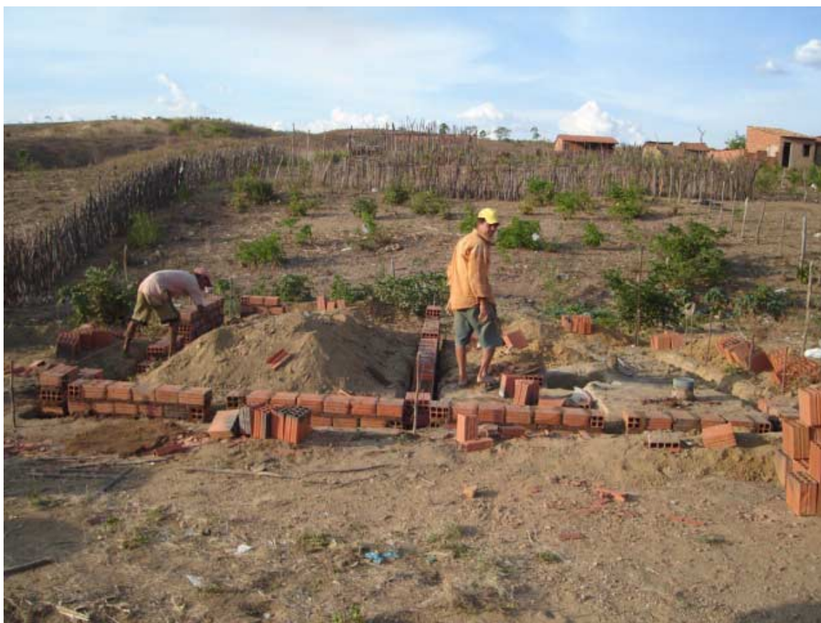
Foto 7.1 - Fase construtiva inicial do SSA Sítio Cidade II
