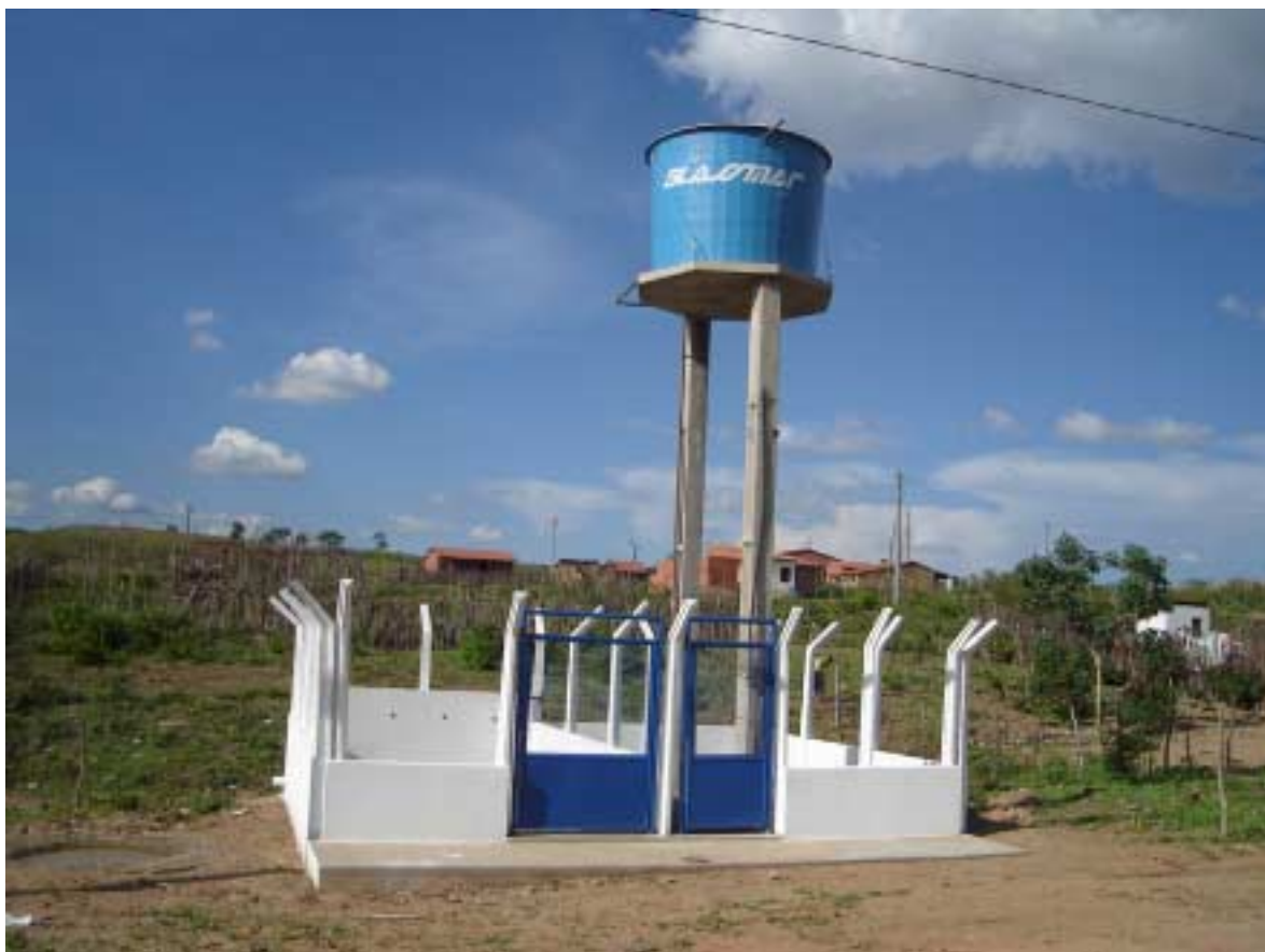
Foto 7.3 - Estrutura e caixa d'água elevada Sítio Cidade II
