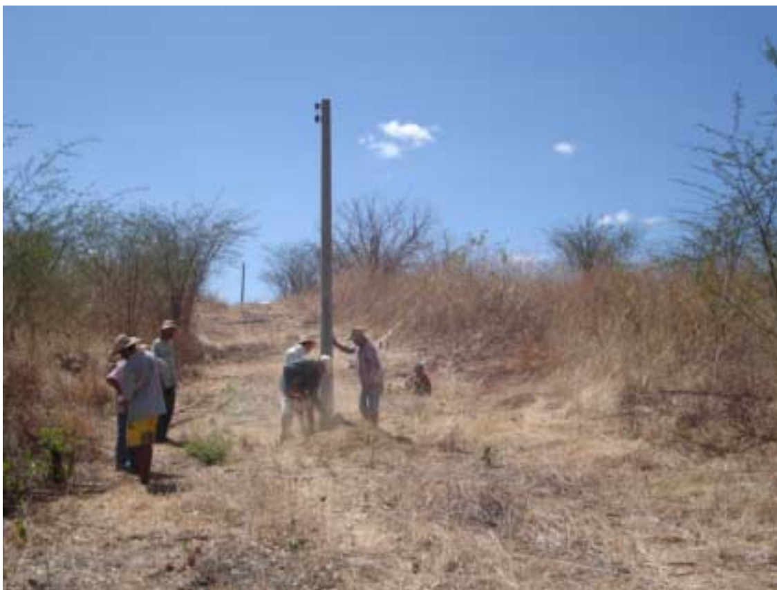
Foto 7.2 - Implantação da extensão da rede de energia elétrica
