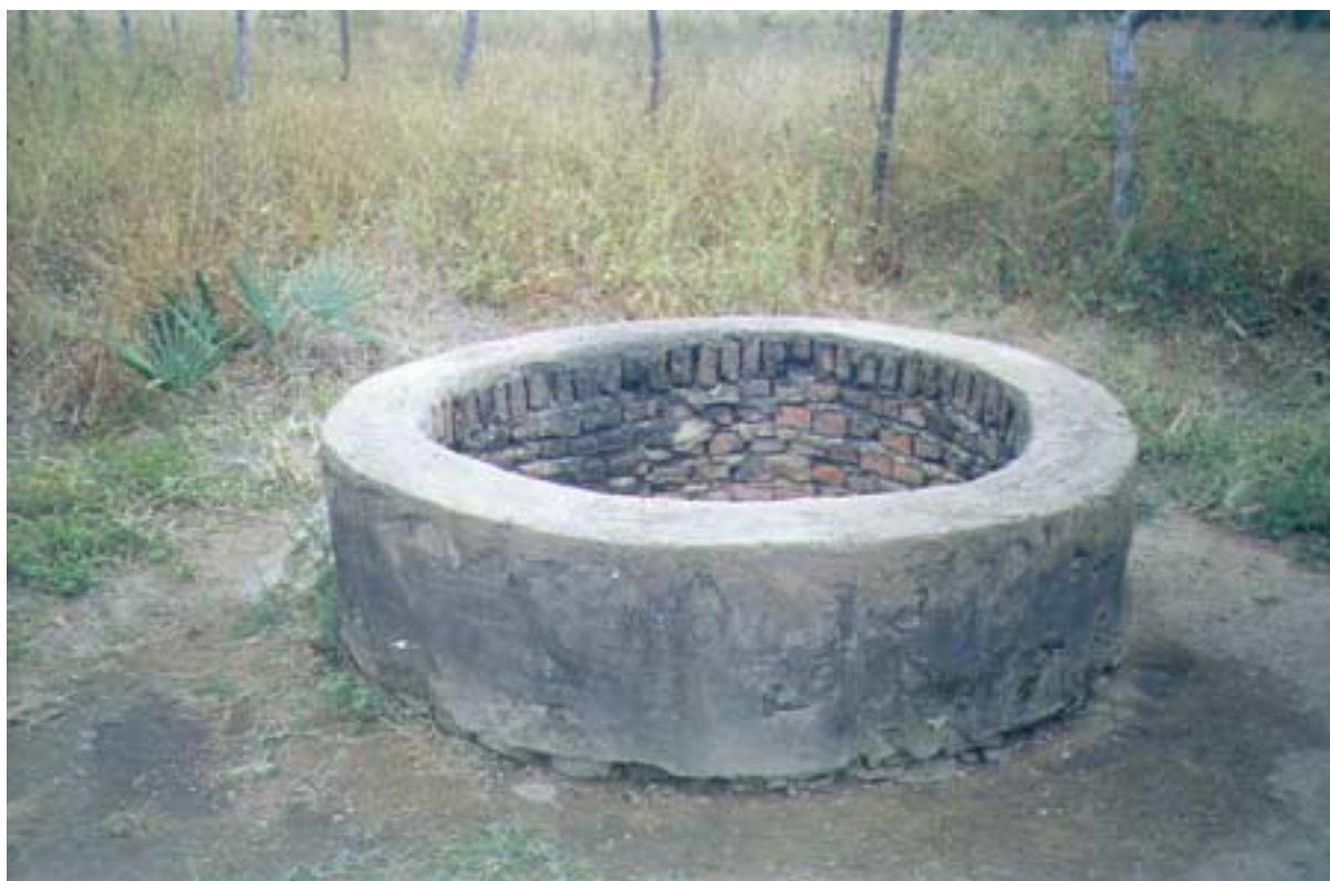
Foto 2.1 - Situação pretérita do poço
