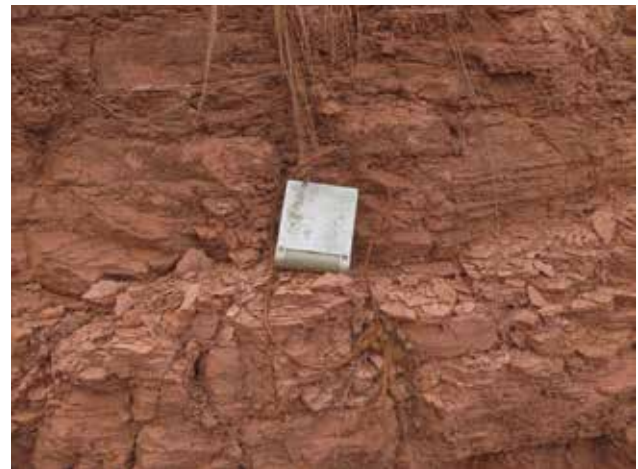
Figura 3.14 - Pelito alterado em corte de estrada (RD-1218, UTM 534674E, 7994133N)
