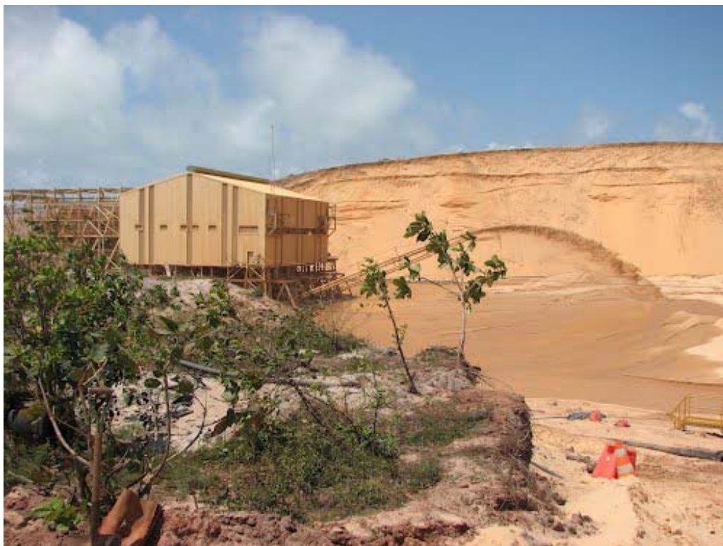
Figura 5.2 – Depósitos eólicos vegetados sendo explotado para retirada de minerais pesados na jazida de Guaju, litoral de Mataraca – PB.
