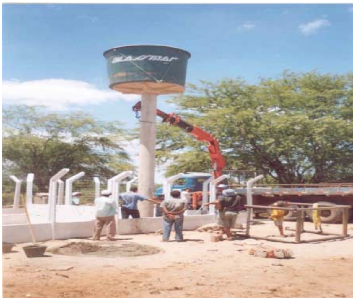
Foto 7.1 - Instalação da caixa elevada do Sítio Brejo do Prioré
