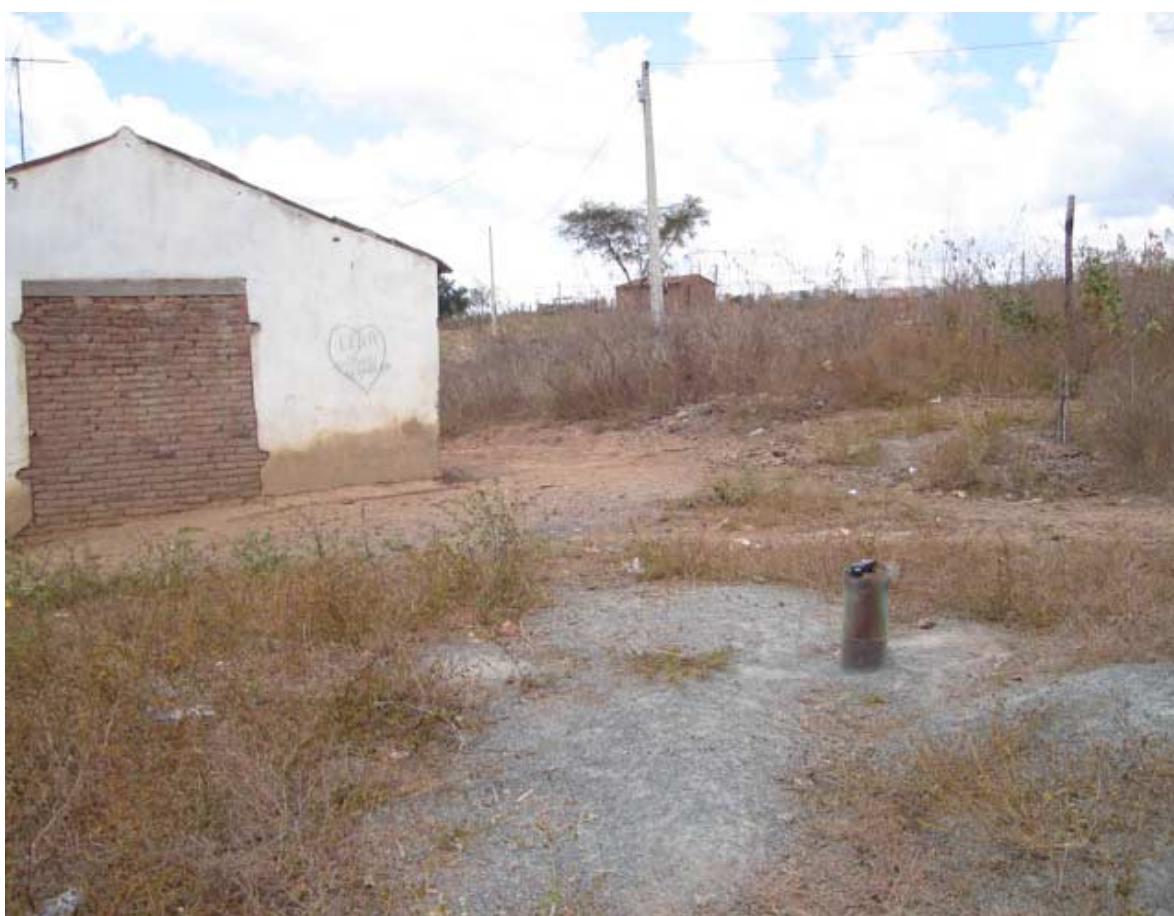
Foto 2.1 - Situação pretérita do poço do Sítio Caraíbas
