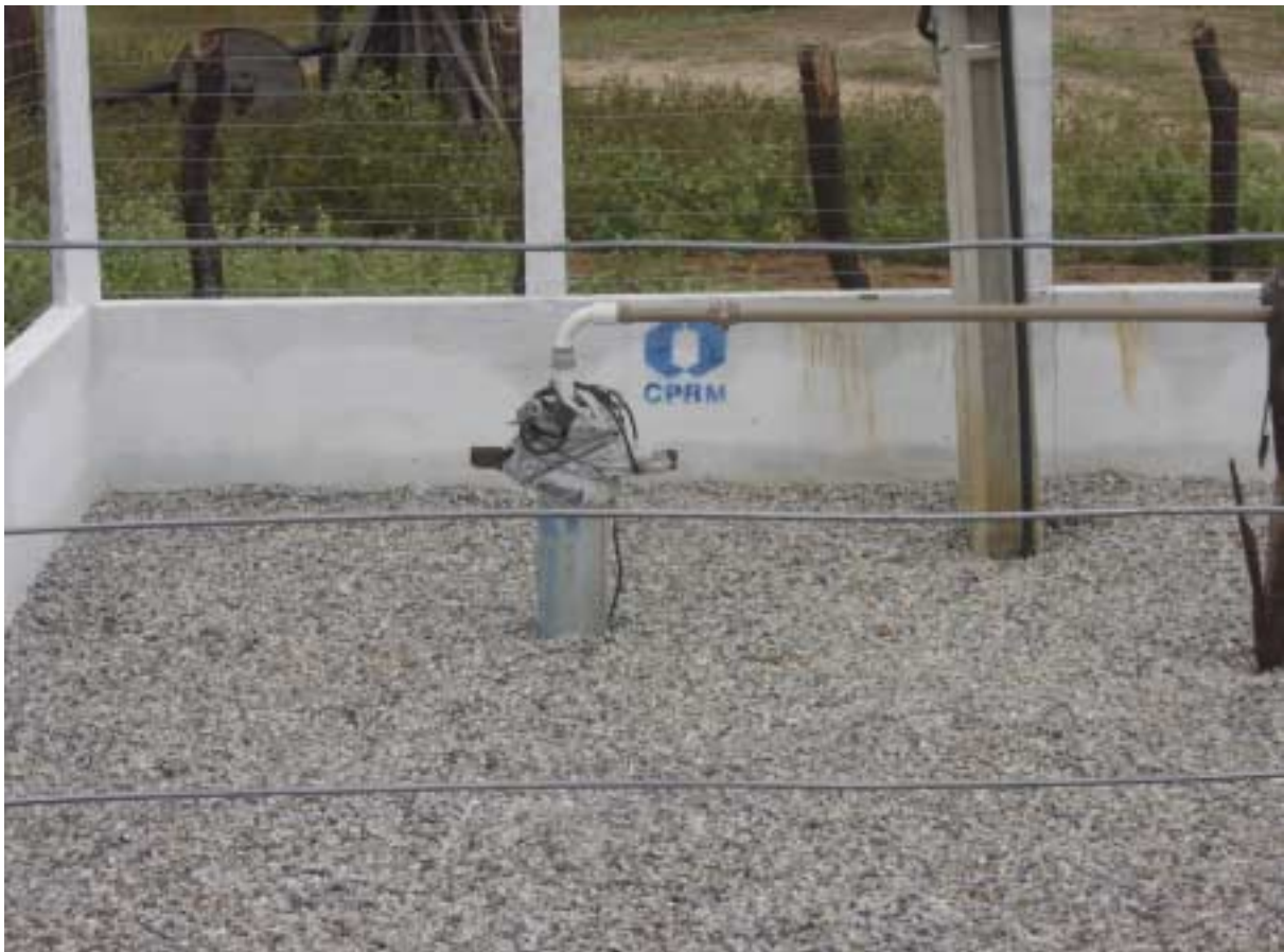
Foto 7.1 - Área interna do SSA Sítio Salgado
