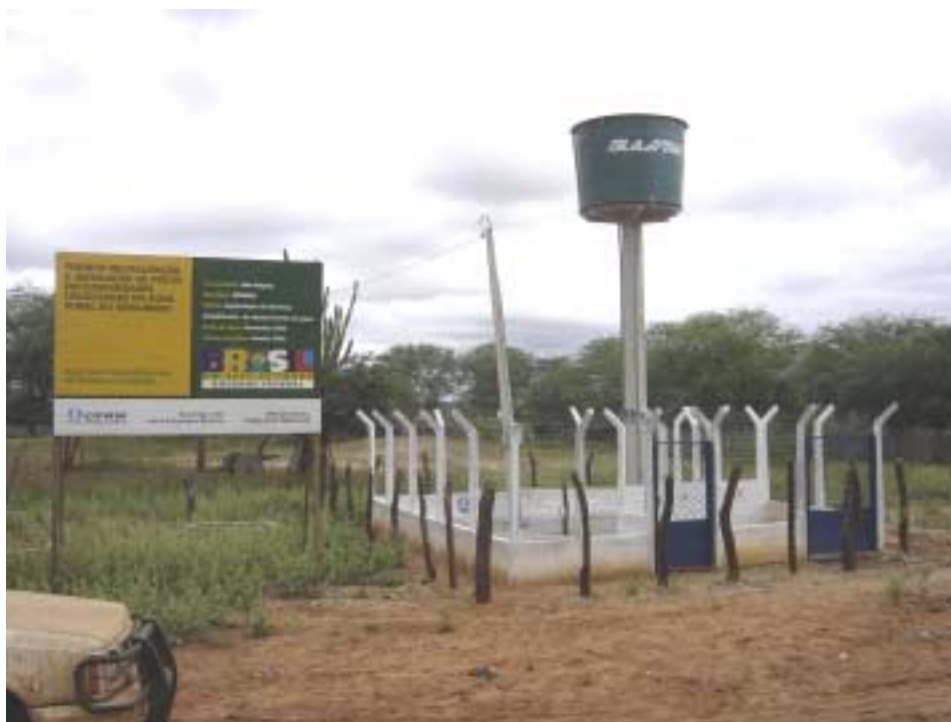
Foto 8.1 - Aspecto do SSA Sítio Salgado concluído
