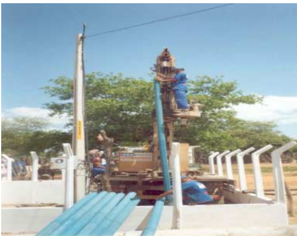
Foto 5.3 – Operação de revestimento do poço HS070
