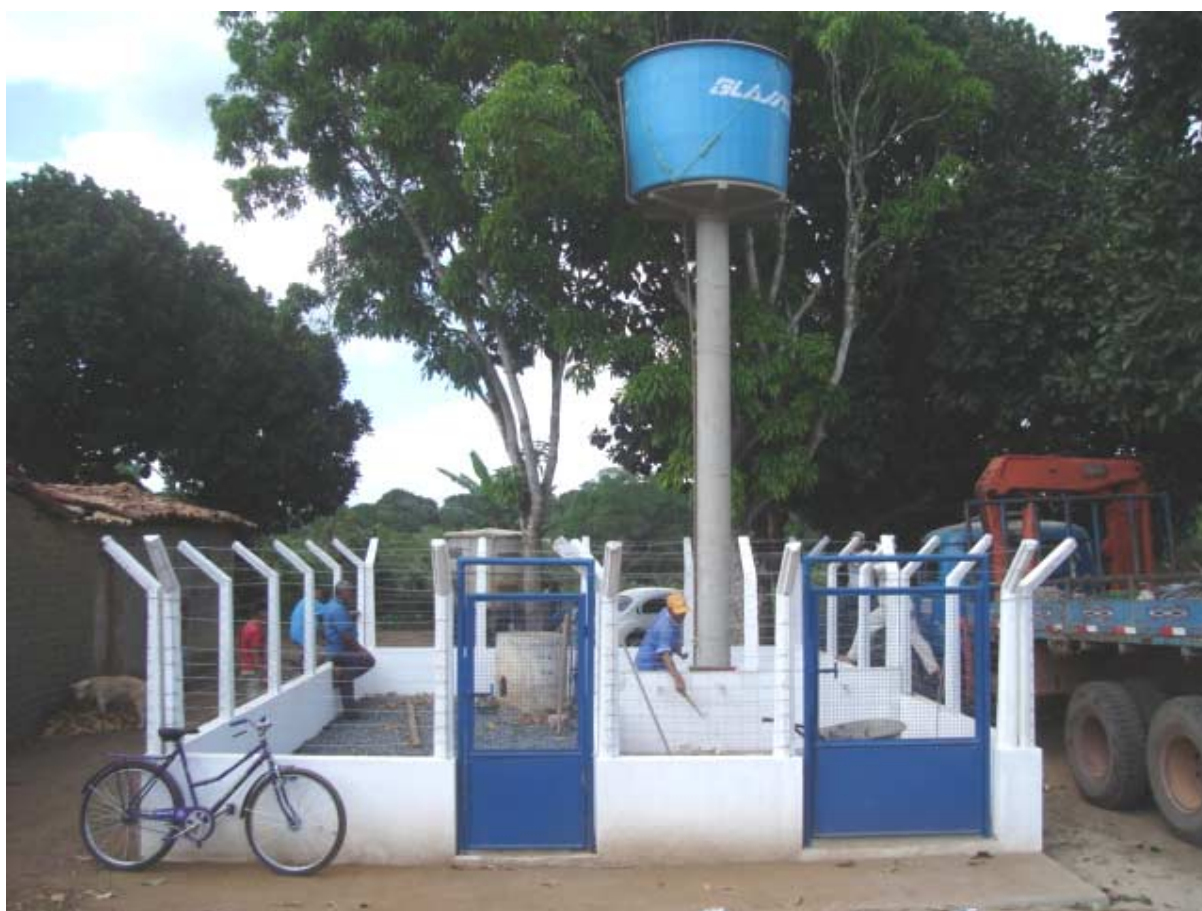
Foto 8.1 - SSA Sítio Jenipapo na fase final de conclusão
