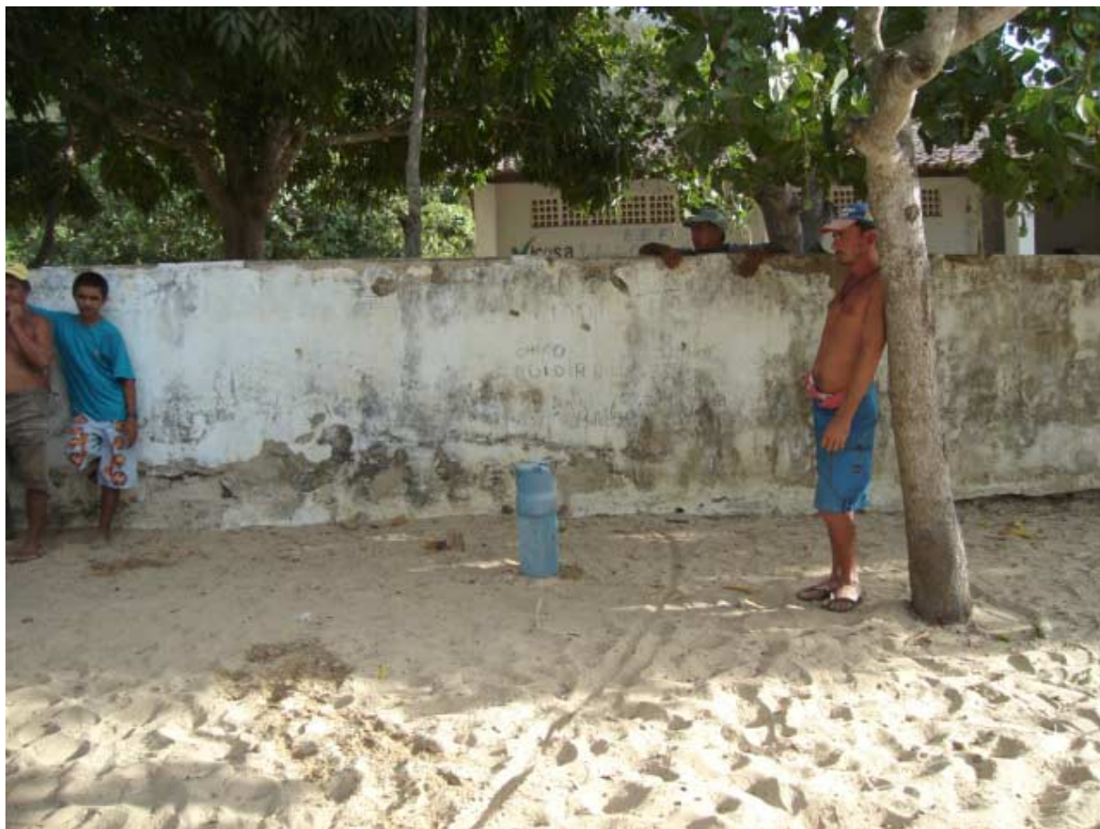
Foto 5.1 - Diagnóstico técnico do poço
