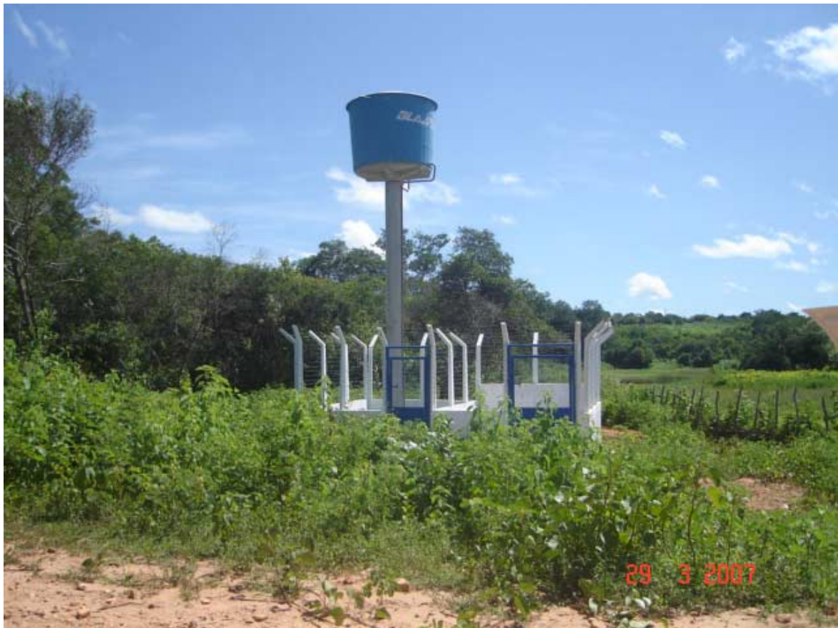
Foto 6.2 - Aspecto do SSA Sítio Pilões concluído
