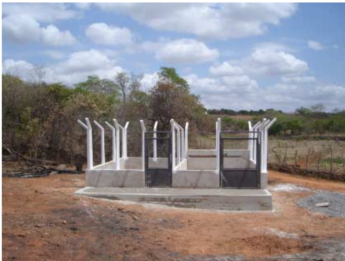
Foto 6.1 - Fase construtiva do SSA Sítio Pilões.
