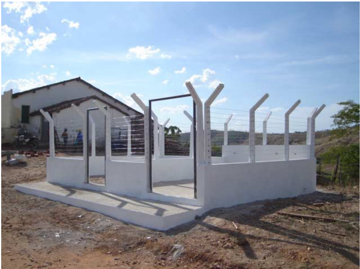
Foto 7.2 - Aspecto da construção SSA Sítio Escondido
