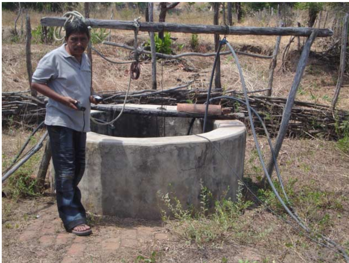
Foto 5.1 - Diagnóstico técnico do poço do Sítio Escondido
