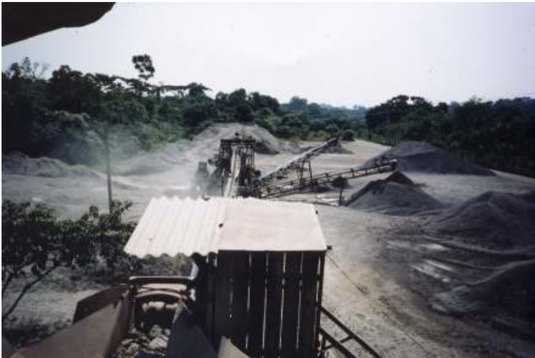
Foto 6 - Vista geral da planta de beneficiamento do minério. Luiz Antonio-nov/2002
