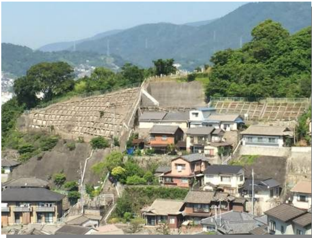
Foto 19: Obras de contenção preventivas implantadas na cidade de Kure.
