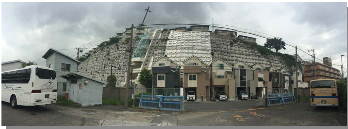
Foto 32: Visita de campo a obra de contenção implantada no Município de Yokohama.
