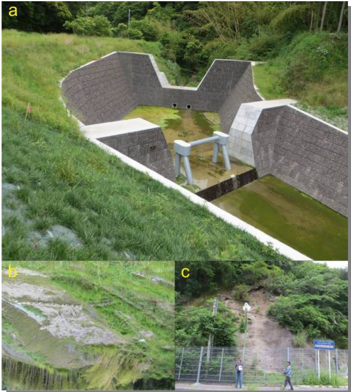
Foto 22: Locais visitados no dia 02 de junho. a) Barragem SABO; b) Deslizamento de Hegurishimo com valas de drenagem, galerias, etc.; c) Estrutura contra queda de blocos.
