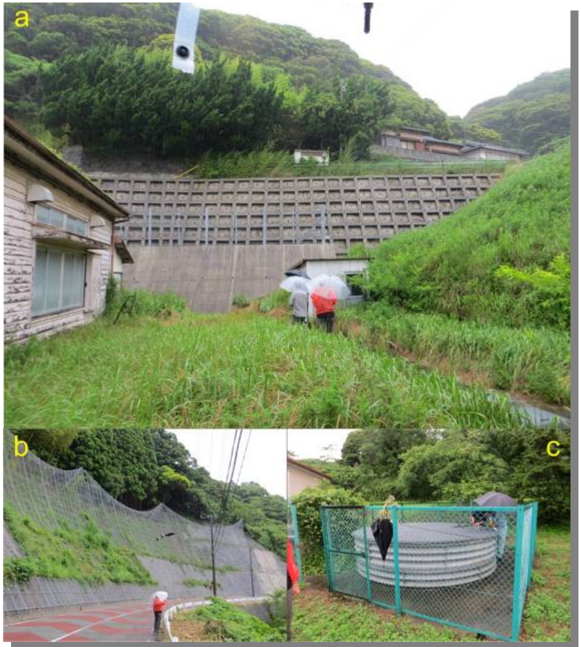
Foto 23: Locais visitados no dia 03 de junho. a) Muro de contenção em encosta íngreme; b) Estrutura contra queda de blocos; c) Poço de drenagem de encosta.
