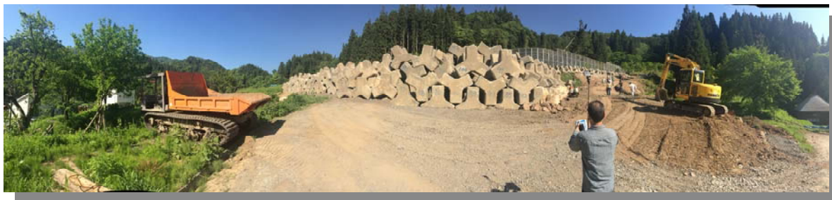
Foto 13: Obra de contenção após ocorrência de desastres naturais em encosta na Província de Nagano.
