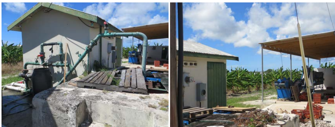
Foto 4. Poço produtivo. a) Aspecto do poço escavado com controle de produção por hidrômetro; b) cultura ao fundo irrigada com água do poço.
