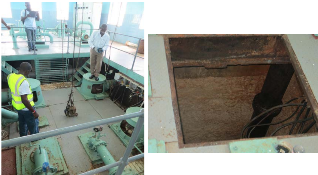
Foto 5. Poço produtivo escavado com equipamento para monitoramento acoplado. a) Tubulações das bombas; b) aspecto das paredes do poço, com as fiações das bombas.
