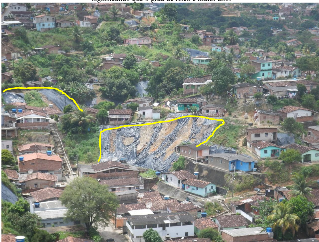
Figura 19 – Superfícies de ruptura observadas nas vertentes, indicam que há um processo instalado significando que o grau de risco é muito alto.
