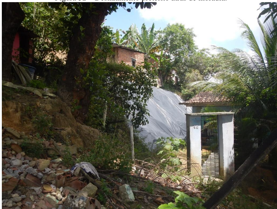
Figura 32 – Deslizamento pretérito atrás de moradia.
