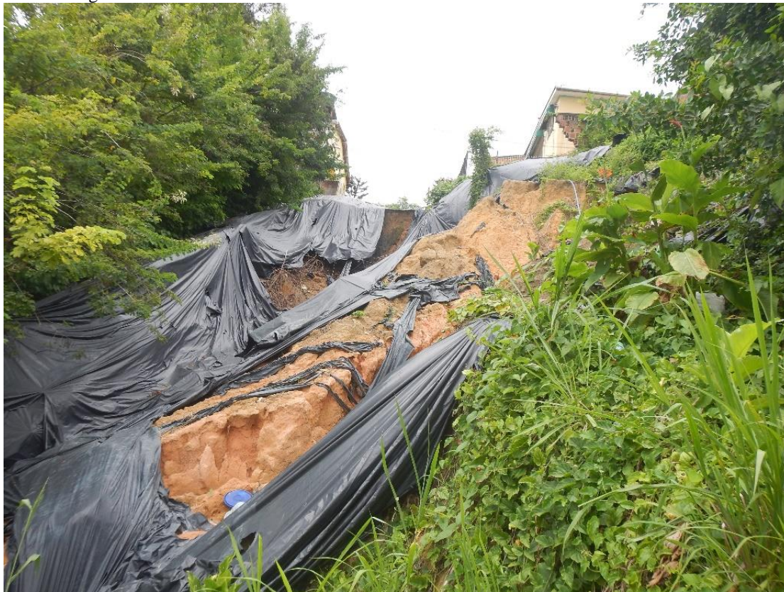
Figura 40 – Cicatriz de deslizamento dentro da área crítica no Alto do Santo Antônio.
