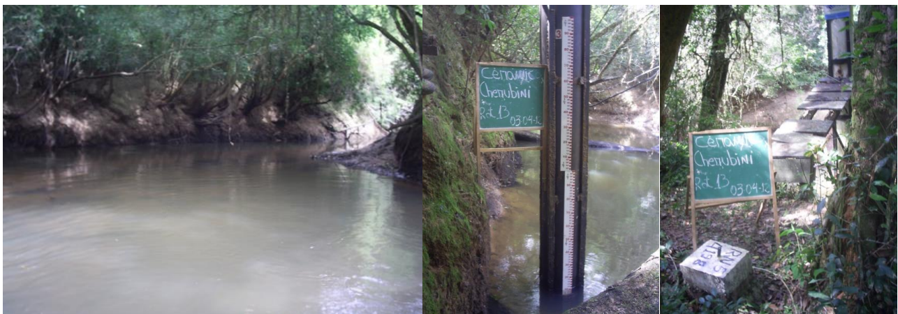
Figura 2 – Foto rio Gravataí e da seção de réguas da estação fluviométrica 87401600.
