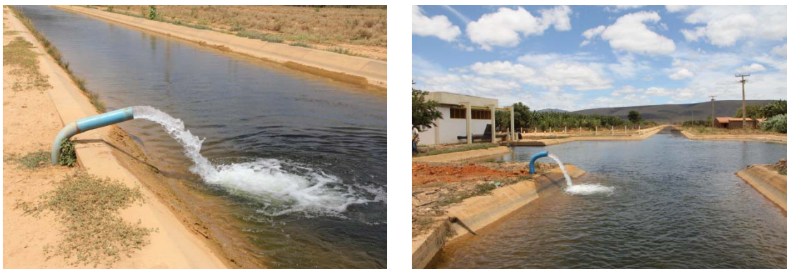
Foto 08 – Poços bombeando e lançando água no canal de irrigação.
