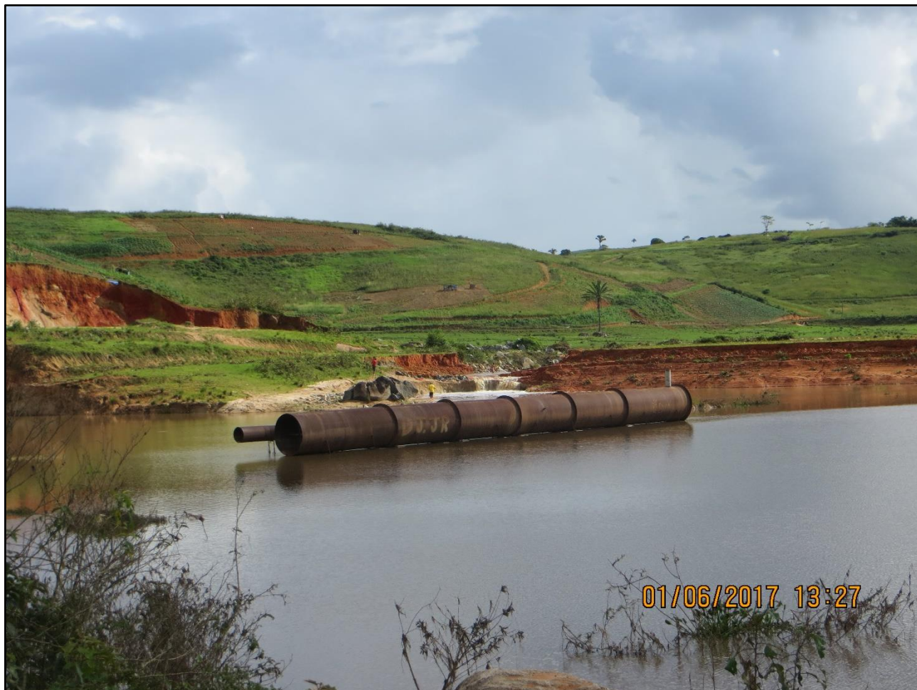
Foto 03: Barragem de Barra de Guabiraba inacabada, observam-se restos sucateados de material da construção da barragem.
