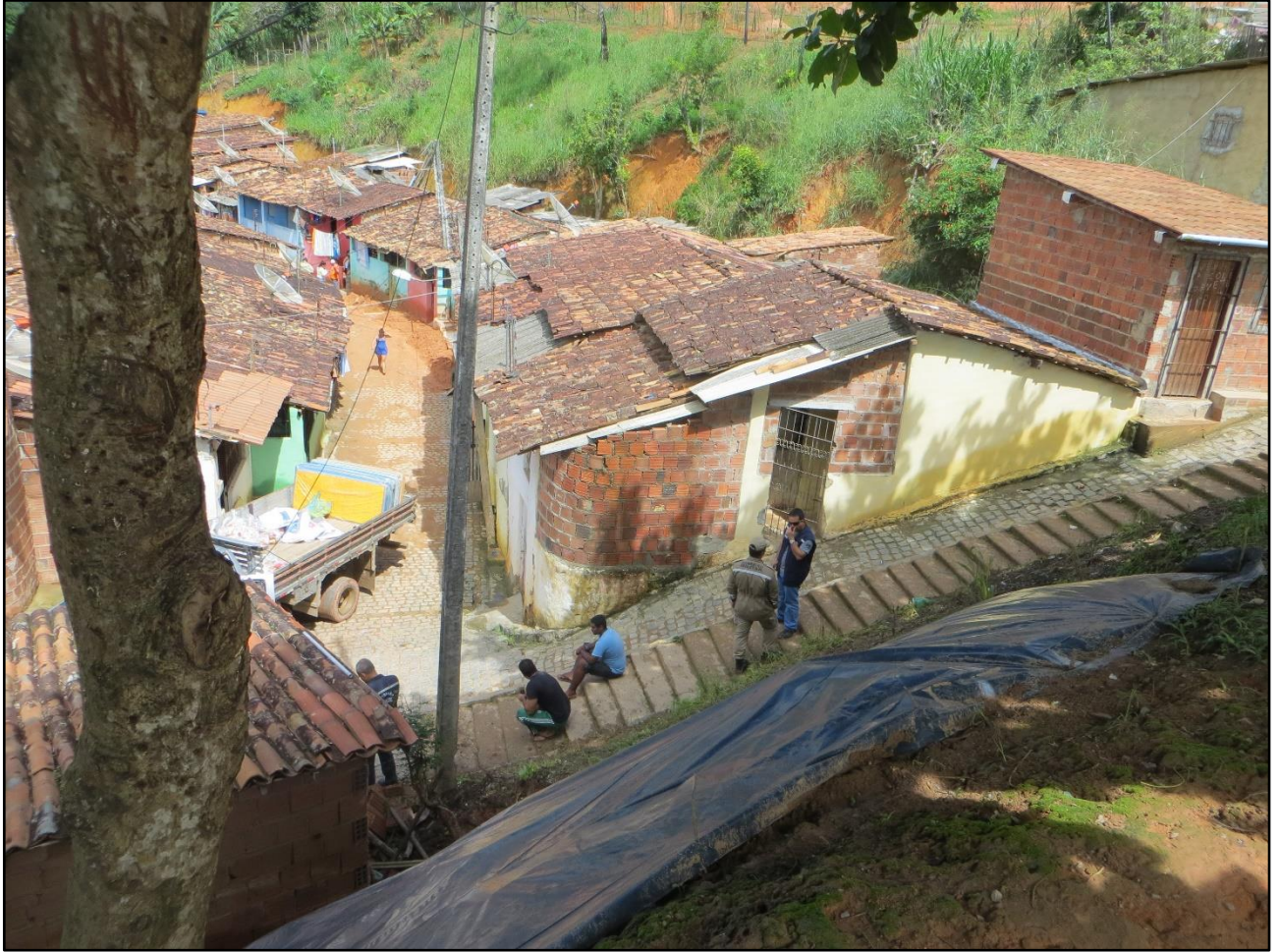
Foto 07: Lonas plásticas já instaladas pela Defesa Civil Municipal em parceria com os Bombeiros Militares da CODECIPE-Casa Militar do Estado de Pernambuco, para uso como proteção provisória, nas encostas da Rua da Palha-Rua da Barreira.
