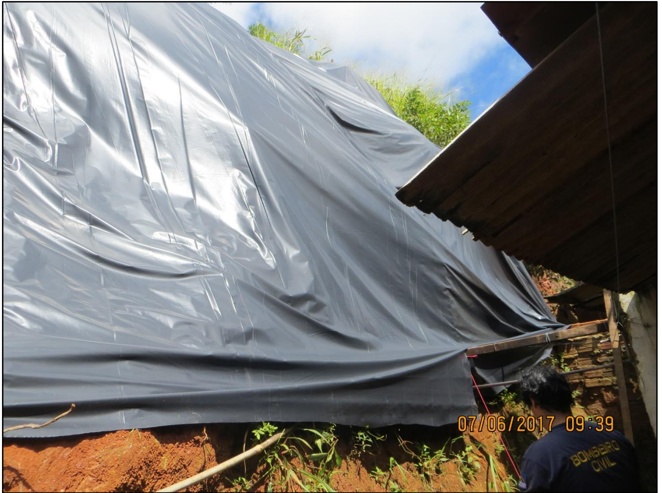
Foto 08: Lonas plásticas já instaladas pela Defesa Civil Municipal em parceria com os Bombeiros Militares da CODECIPE-Casa Militar do Estado de Pernambuco e Bombeiros Civis, para uso como proteção provisória.
