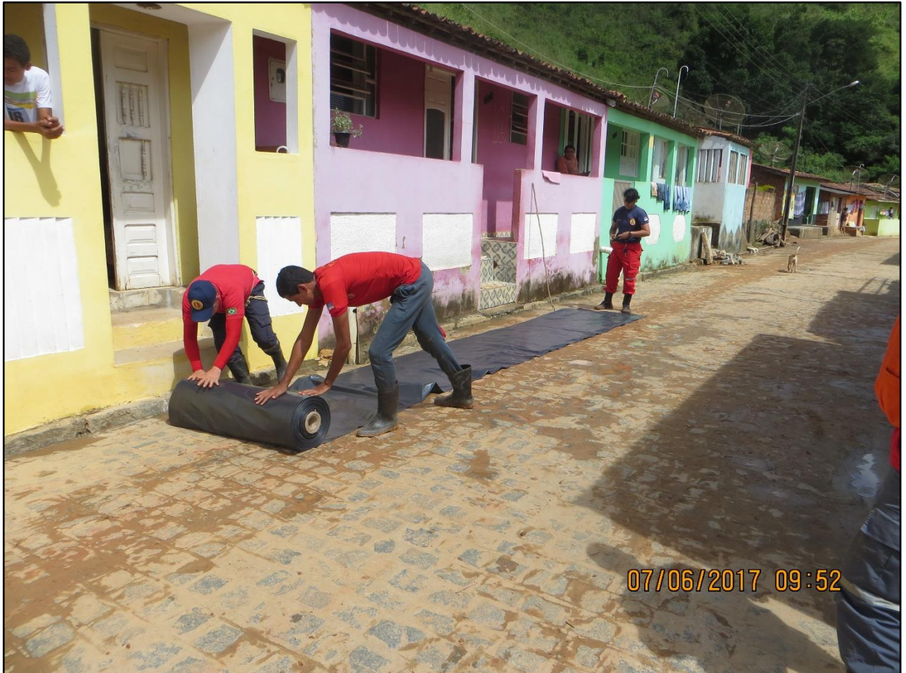
Foto 06: Lonas plásticas sendo desenroladas pela Defesa Civil Municipal em parceria com os Bombeiros Militares da CODECIPE-Casa Militar do Estado de Pernambuco e Bombeiros Cíveis, para uso como proteção provisória.
