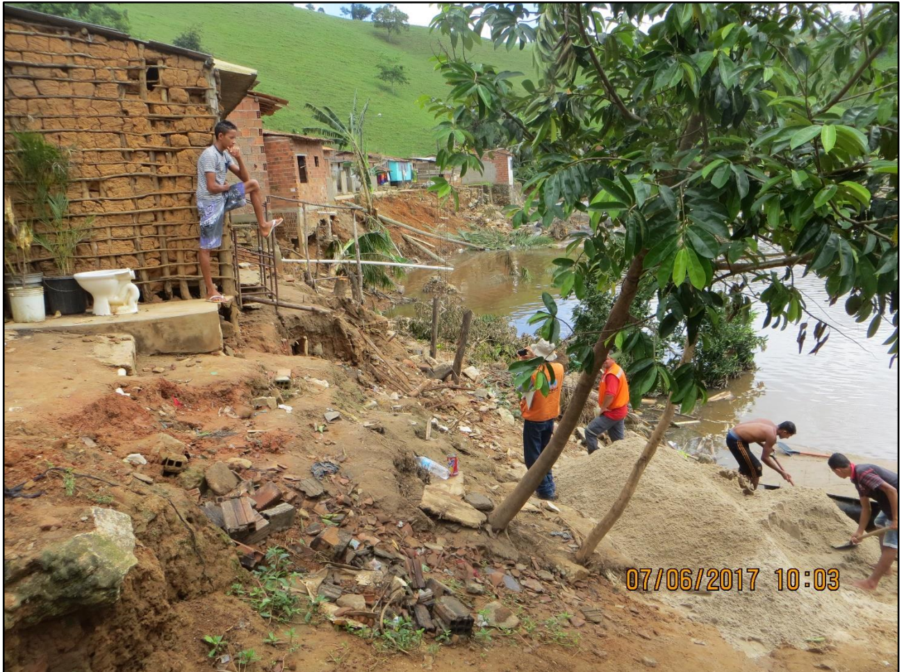
Foto 03: Solapamento das margens do Rio Pirangi, provocado pelas inundações de 05/2017, erodindo a base das casas ribeirinhas de Maraial-PE. Observa-se a reconstrução das moradias, as quais haviam sido destruídas pela inundação do rio, no mesmo local impróprio e proibido pela legislação ambiental.
