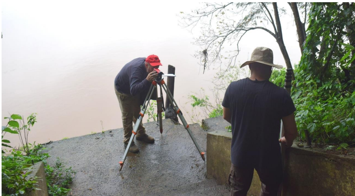
Figura 33. Instalação de réguas linimétricas na estação Estrela, em Lajeado, outubro de 2021. Fonte: Hautrive (2021).
