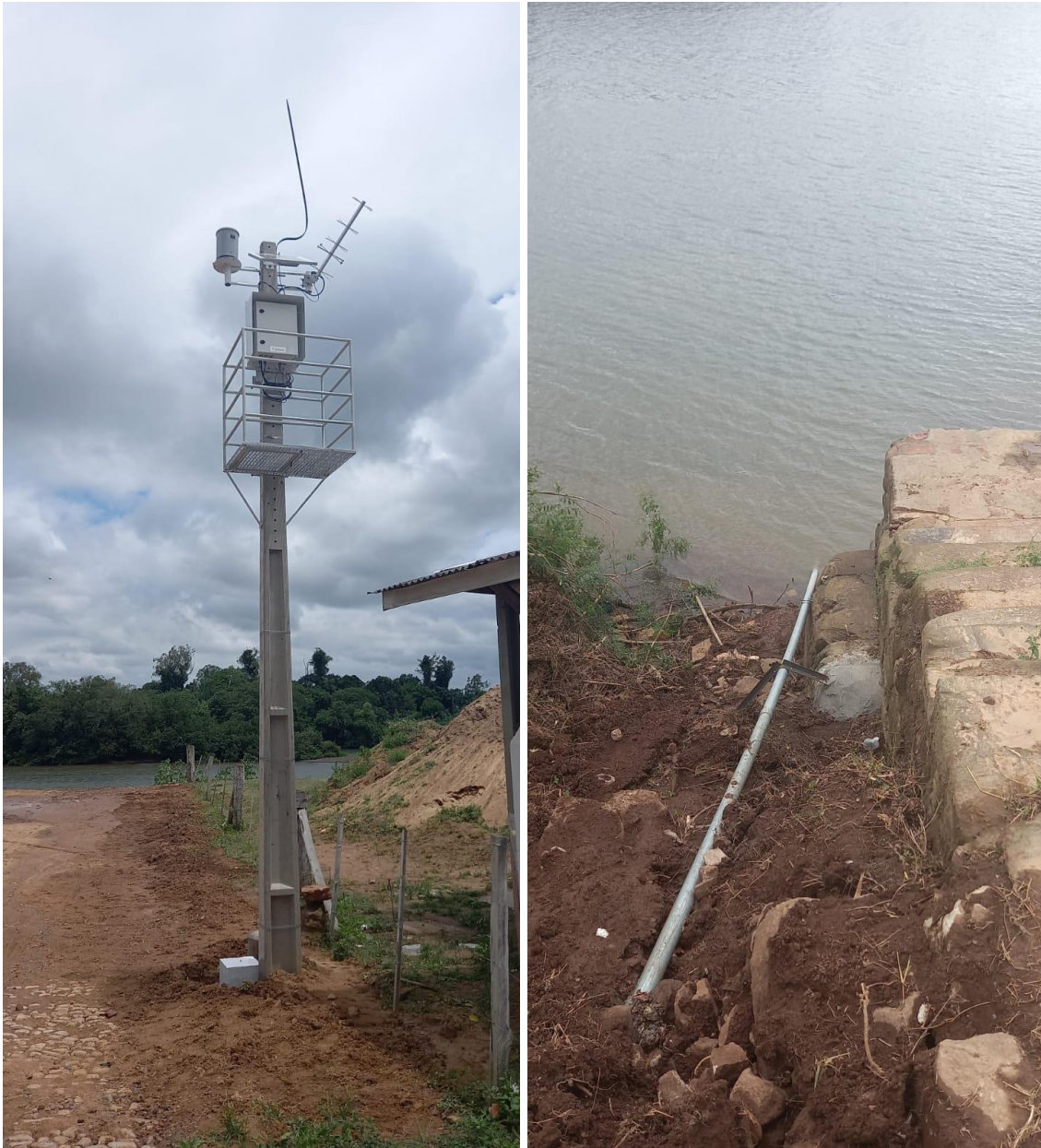
Figura 34. Instalação de PCD com transmissão GOES na estação Taquari, novembro de 2021.
