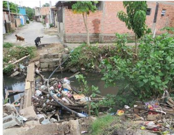
**Figura 4** - Pontilhão de pedestres improvisado por moradores após o existente ter sido levado pela correnteza. Final da rua P-Sete.
