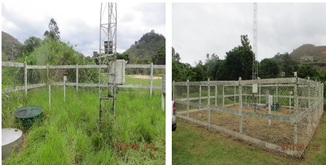
Figuras 3 e 4 - Estação Parque Petrópolis antes e depois da manutenção.
