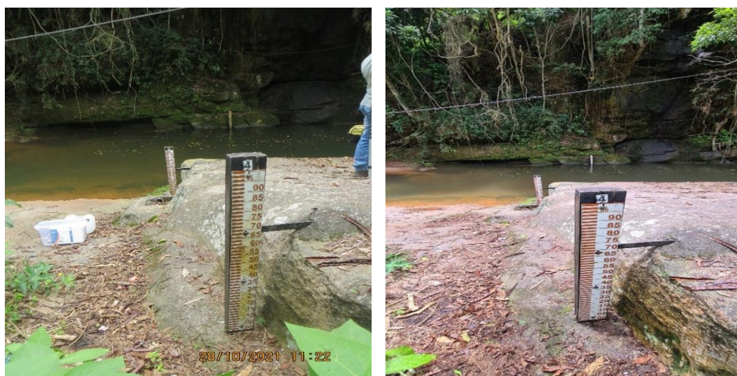
Figuras 5 e 6 - Estação Parque Petrópolis antes e depois da manutenção.
