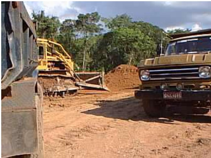
Figure 3.14 – Dépôts de Déchets du Aurá – lieu d'exploitation de matériaux utilisé comme couverture de déchets, cas Horizon Ferrugineux, faciès Concrétionnaire.
