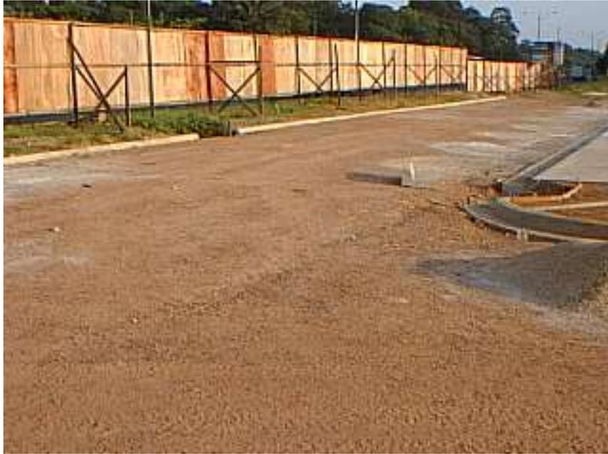
Figure 3.13 – Horizon Ferrugineux, faciès Concrétionnaire, utilisé comme couche de chaussées en ensembles résidentiels (Route . Augusto Montenegro, Belém-Icoaraci).
