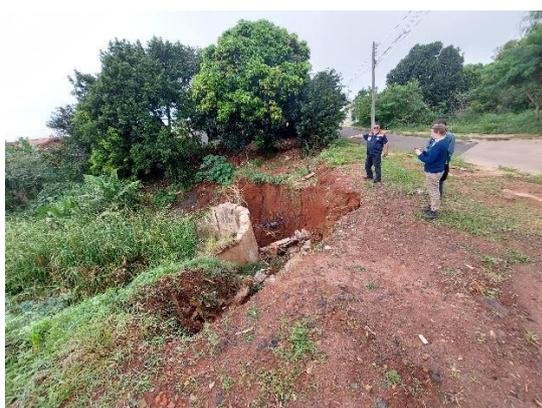
Figura 5 – Estrutura danificada por vazão acima de sua capacidade e/ou obstrução por detritos.
