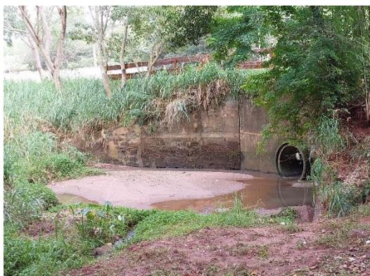
Figura 3 – Manilha danificada por vazão acima de sua capacidade.
